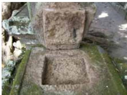
Sistem pengunci sambungan horizontal adalah pengunci sambungan antara dua batu yang berdampingan di kanan kiri yang berada dalam satu lapis. Pengunci dapat berupa batu kerakal berbentuk lonjong, dan batu yang dipahat bentuk ekor burung. Pemasangan batu pengunci dengan cara melubangi kedua batu sehingga membentuk cekungan sesuai bentuk batu pengunci.
