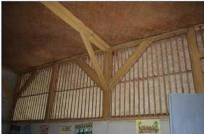
Detail penguat kuda-kuda agar tetap tegak lurus pada posisinya (foto Dok. BPCB)
