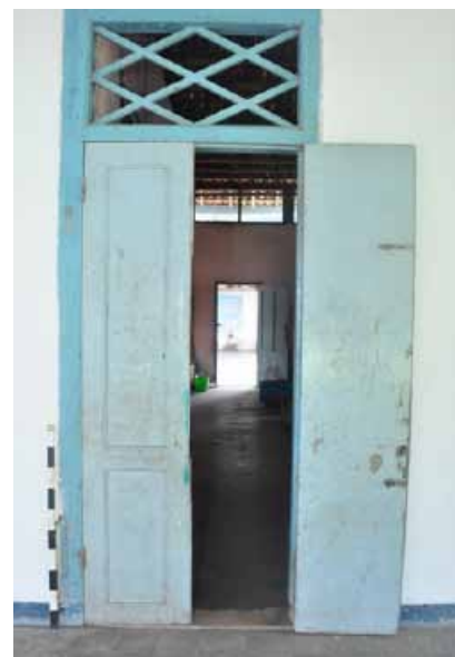
Foto No. D150285 Pintu masuk tengah bangunan induk
