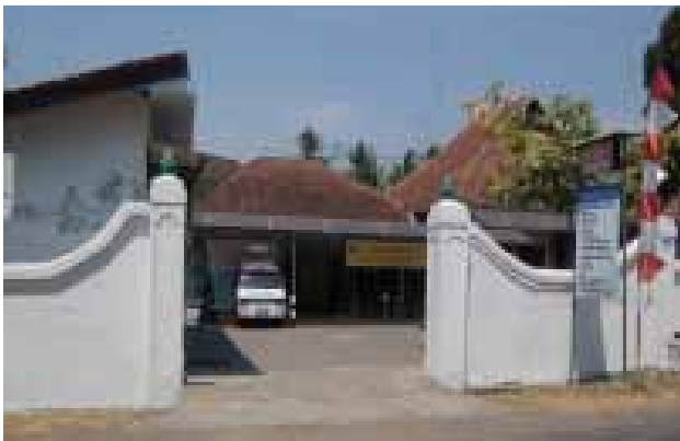
Foto no. D152782 Pintu gerbang Rumah Sakit St. Yusuf Boro
