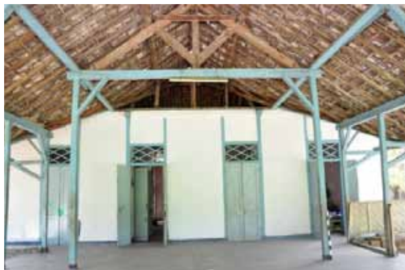
Foto no. D150153 Situasi ruang pendapa
