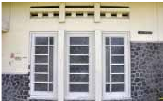
Jendela dan ventilasi pada dinding sisi selatan
