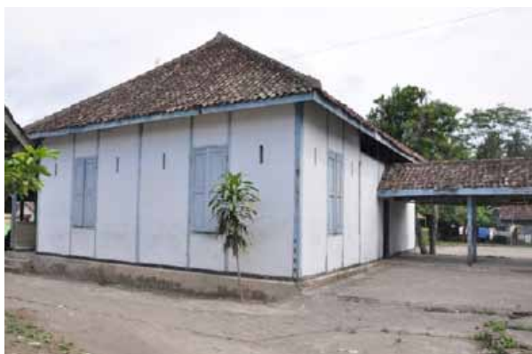
Foto No. D150203 Bangunan Induk dilihat dari Timur Laut
