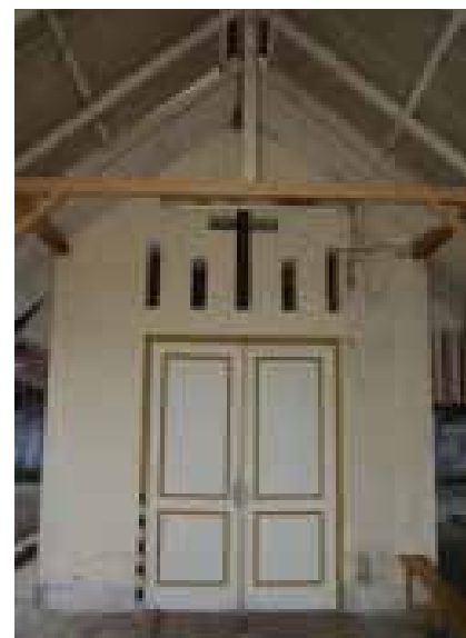
Foto No D152600 Tampak depan Ruang Perawatan jenazah
