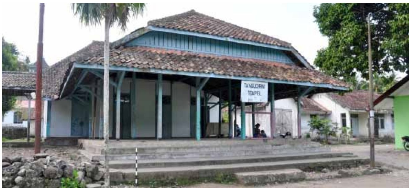
Foto No. D150110, Situasi bangunan Kapanewon Tempel menghadap ke arah selatan, tampak barat daya
