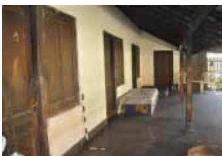
Situasi bangunan bagian belakang
