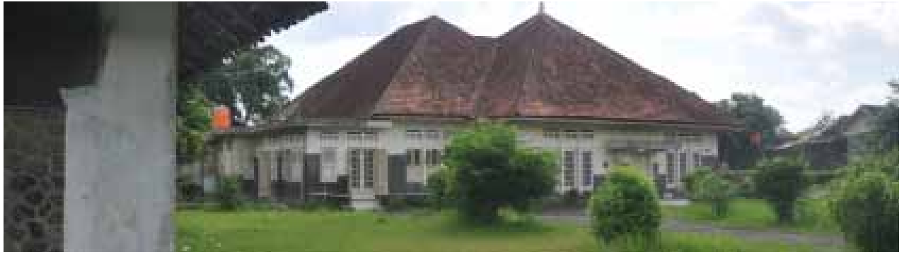
Situasi bangunan rumah dan paviliun di sisi barat
