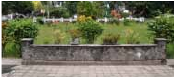
Pembatas di sebelah selatan drop off area, dilihat dari utara
