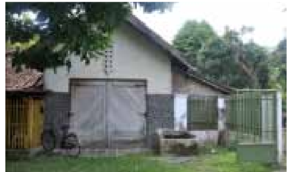
Bangunan untuk garasi
