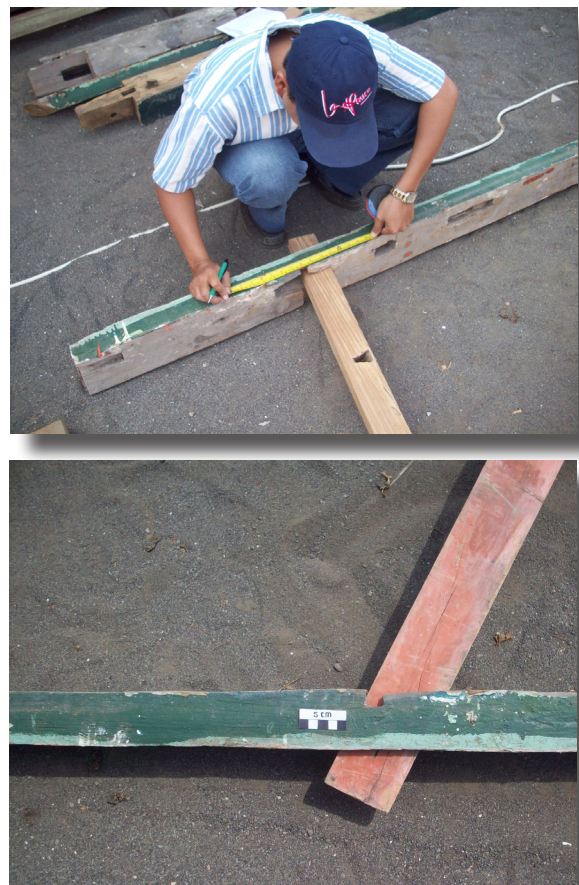
Foto 1. Pengukuran kemiringan lubang usuk panerus pada takir tadhahlas
