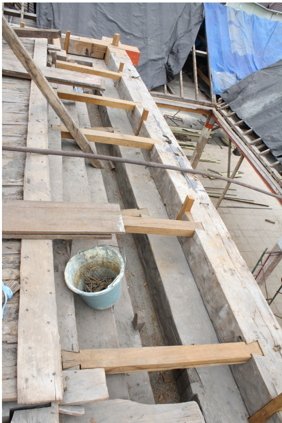
Foto 3. Tanpa adanya lubang gondomaru pada balandar lar-laran paling atas.
