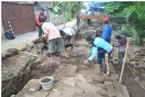
Foto 5. Kegiatan pembongkaran batu tufa benteng
