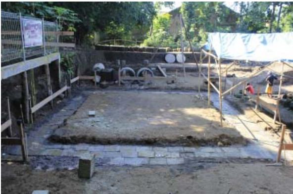
4. Hasil pemasangan batu tuff untuk perkuatan struktur pondasi
