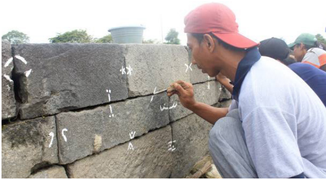
Gambar 6. Registrasi batu insitu (Foto dok. BPCB DIY)
