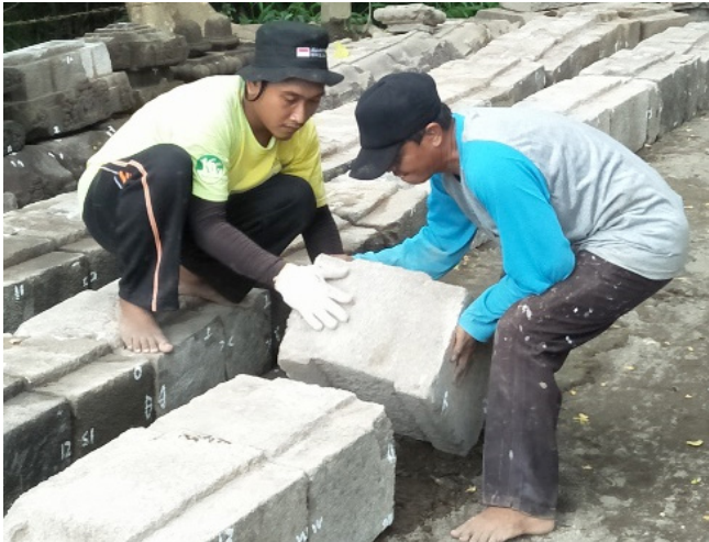
Gambar 13. Kegiatan Pengelompokan & klasifikasi batu insitu hasil pembongkaran Sumber : Dok. BPCB DIY
