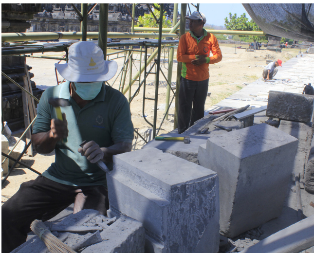
Gambar 22. Pembuatan batu pengganti (Foto: dok. BPCB DIY)
