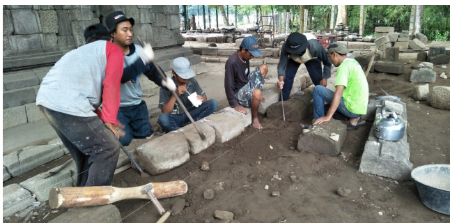
Gambar 25. Kegiatan pembuatan landasan Sumber : Dok. BPCB DIY
