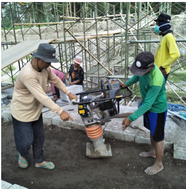
Gambar 32. Kegiatan pemadatan tanah Sumber : Dok. BPCB DIY
