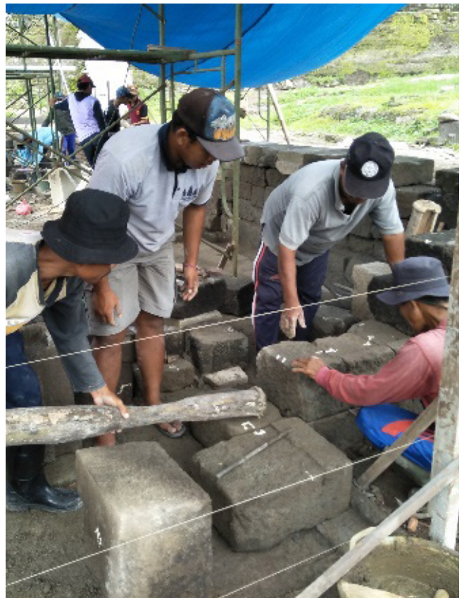
Gambar 33. Penyusunan kembali batu Hasil anastilos (outer stone) Sumber : Dok. BPCB DIY
