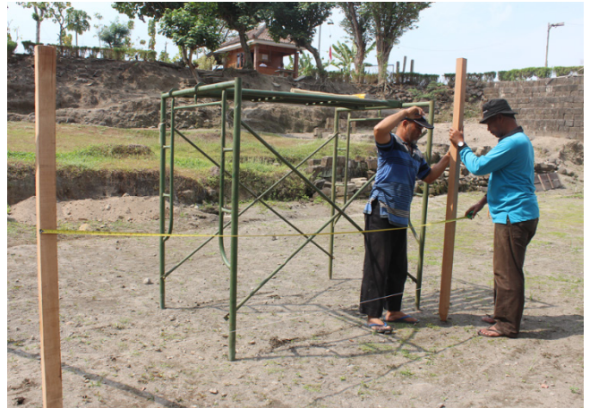
Gambar 8. Pembuatan Bowplank Sumber : Dok. BPCB DIY
