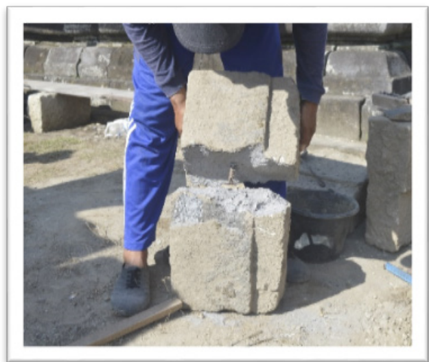
Gambar 28. Proses penempelan fragmen batu dengan tambahan angkur (Foto: dok. BPCB DIY)
