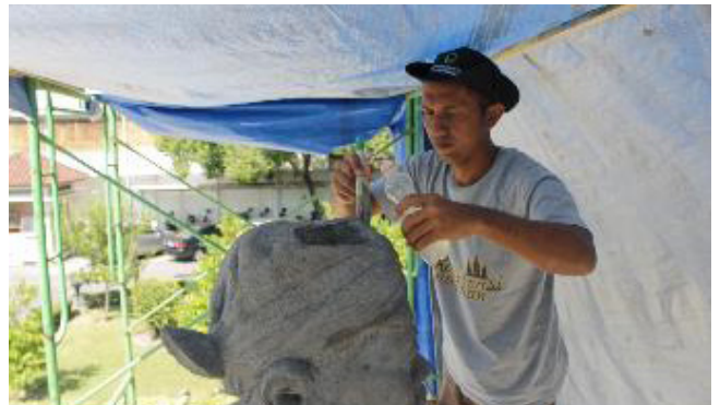
Gambar 16. Penghilangan cat secara lebih detail pada pori-pori batuan dan lipatan-lipatan. (Foto: dok. BPCB DIY)
