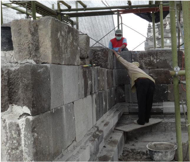
Gambar 21. Kegiatan pemasangan kembali batu kulit (Foto: dok. BPCB DIY)
