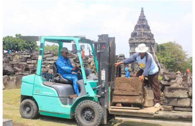
Gambar 16. Pengangkutan batu menggunakan forklift (Foto: dok. BPCB DIY)
