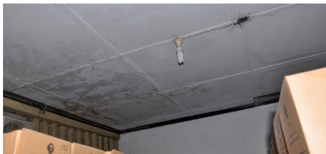
Kebocoran pada atap (Foto: dok. BPCB DIY)
