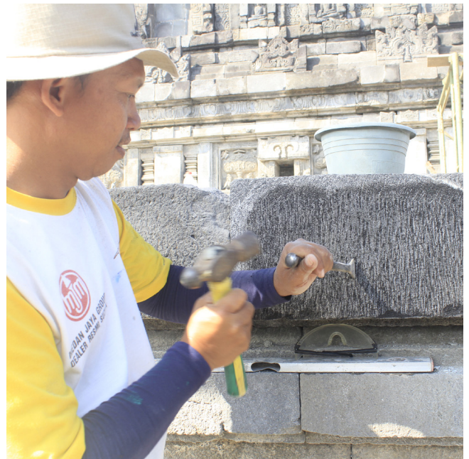
Gambar 23. Kegiatan penyelarasan/ pemahatan halus (Foto: dok. BPCB DIY)
