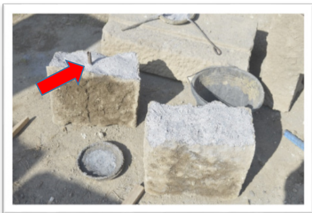
Gambar 27. Proses pemberian angkur dan lem pada fragmen batu (Foto: dok. BPCB DIY)
