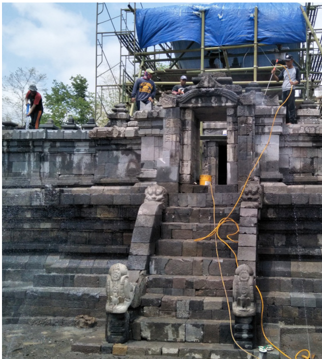
Gambar 47. Pembersihan bangunan candi secara menyeluruh Sumber : Dok. BPCB DIY
