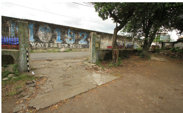
Kondisi beda tinggi antara halaman depan bangunan dengan jalan aspal (Foto: dok. BPCB DIY)
