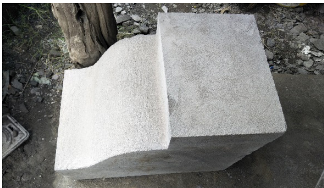
Gambar 24. Hasil Pembuatan batu pengganti Sumber : Dok. BPCB DIY
