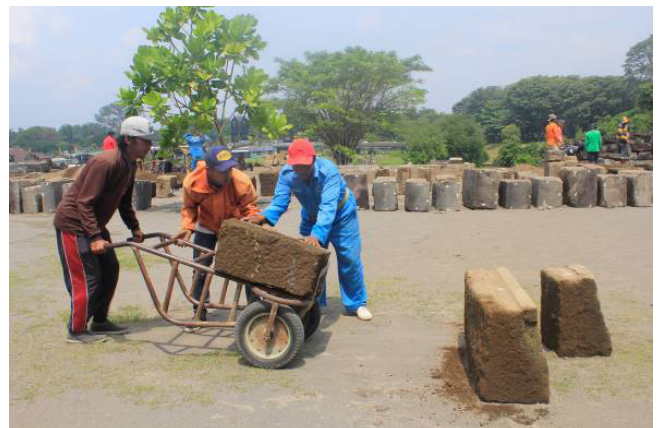
Gambar 17. Pengangkutan batu menggunakan kletek (Foto: dok. BPCB DIY)
