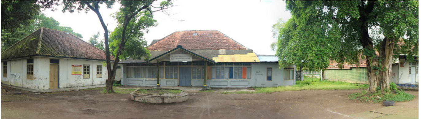
Bangunan Eks Rumah Sakit Mata Yogyakarta tampak depan (Foto: dok. BPCB DIY)
