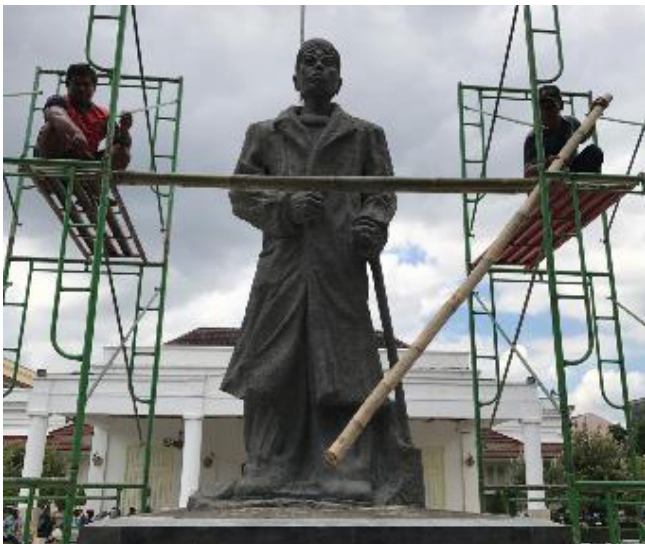
Gambar 21. Kegiatan pembongkaran perancah (Foto: dok. BPCB DIY)
