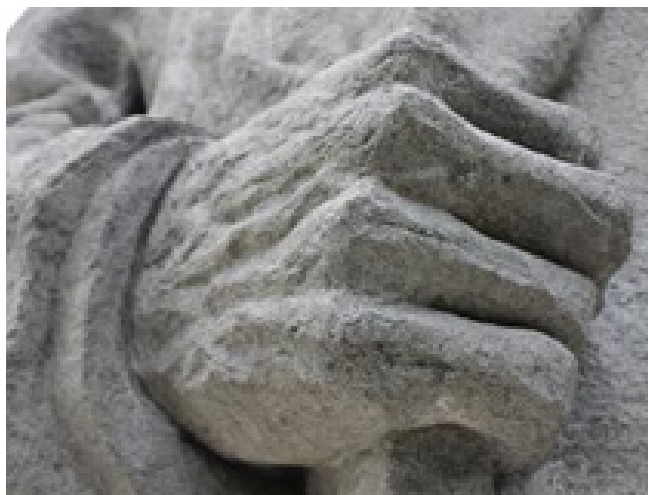
Gambar 25. Detail permukaan batu setelah dibersihkan (Foto: dok. BPCB DIY)
