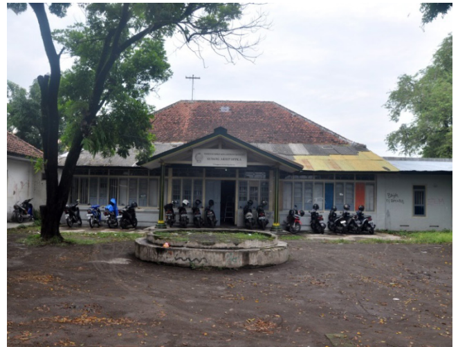
Bangunan A tampak depan (Foto: dok. BPCB DIY)
