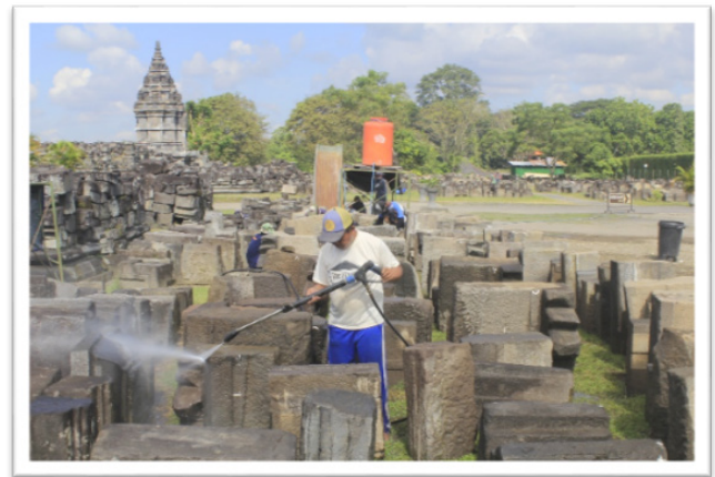
Gambar 25. Pembersihan mekanis basah dengan air bertekanan rendah (Foto: dok. BPCB DIY)
