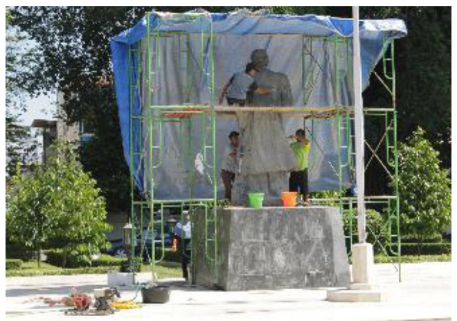
Gambar 18. Pembersihan cat pada bagian punggung. (Foto: dok. BPCB DIY)
