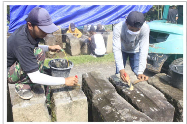
Gambar 26. Pembersihan mekanis kering dengan kuas dan sapu lidi kecil (Foto: dok. BPCB DIY)
