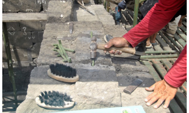
Gambar 17. Pemasangan angkur
