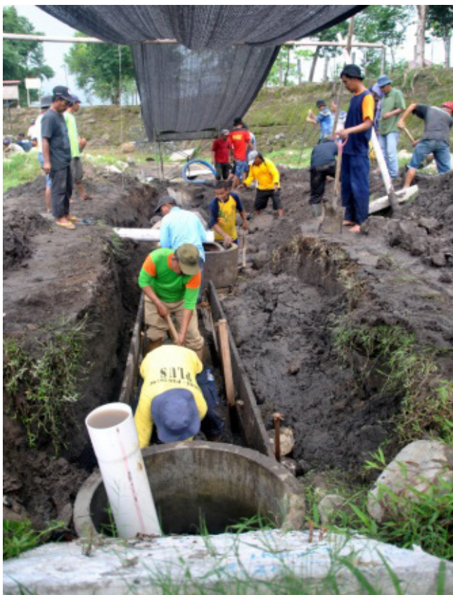
Gambar 4. Pembuatan saluran pembuangan air Sumber : Dok. BPCB DIY
