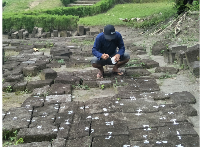
Gambar 11. Registrasi batu Sumber : Dok. BPCB DIY
