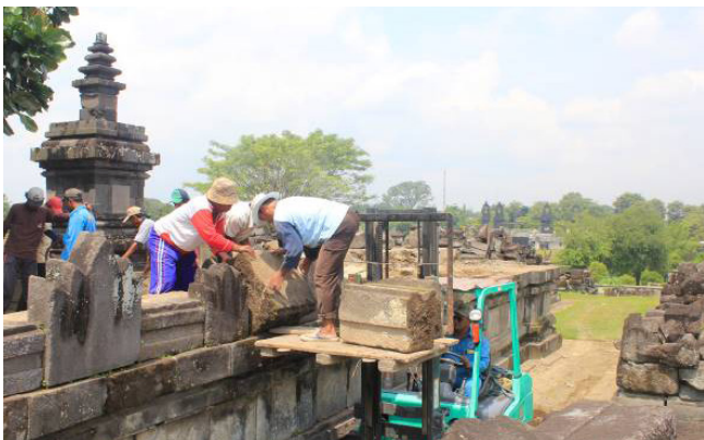
Gambar 7. Pembongkaran batu insitu (Foto: dok. BPCB DIY)
