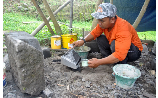
Gambar 21. Penyambungan batu Sumber : Dok. BPCB DIY
