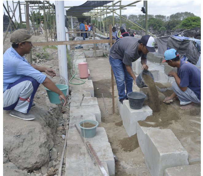
Gambar 20. Pemasangan batu isian/ batu tuff dengan isian pasir (Foto: dok. BPCB DIY)
