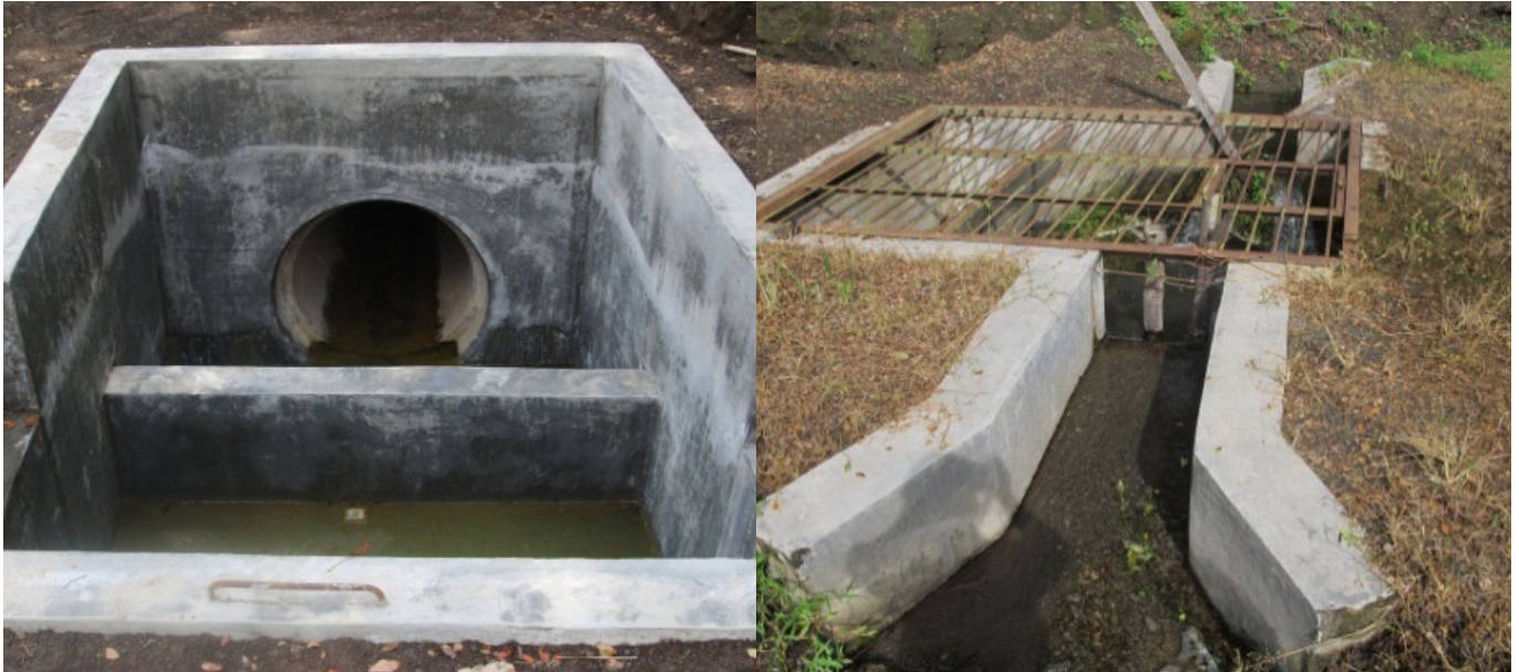
Gambar 3. Pembuatan gorong-gorong dalam rangka penanganan masalah air (Foto: dok. BPCB DIY)
