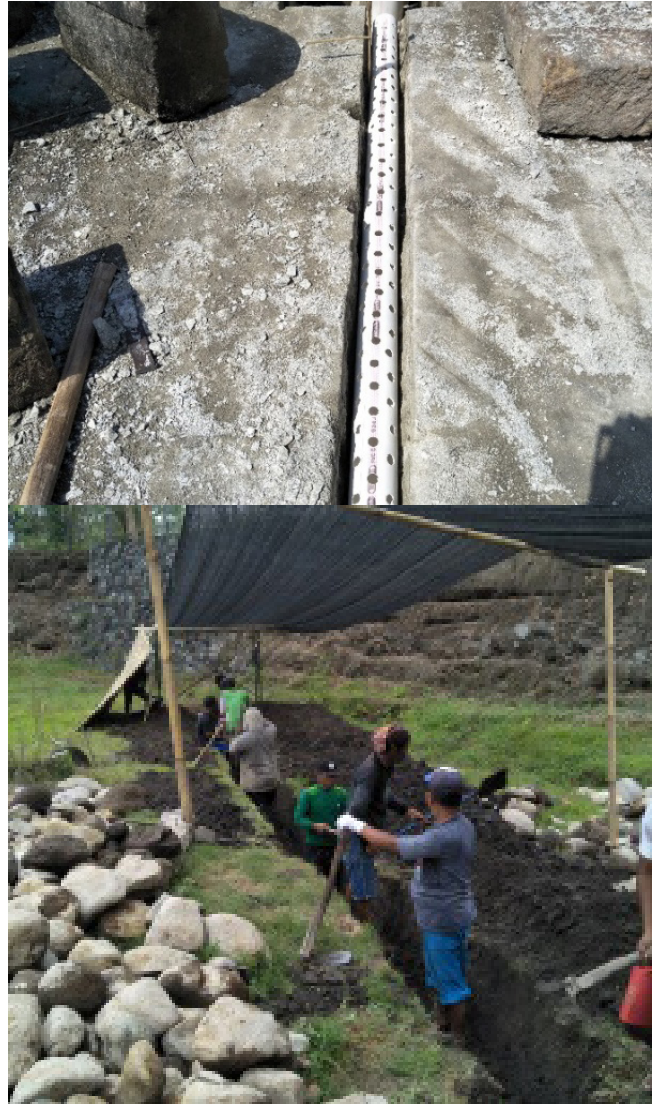
Gambar 39. Kegiatan galian tanah, pemasangan pipa Sumber : Dok. BPCB DIY
