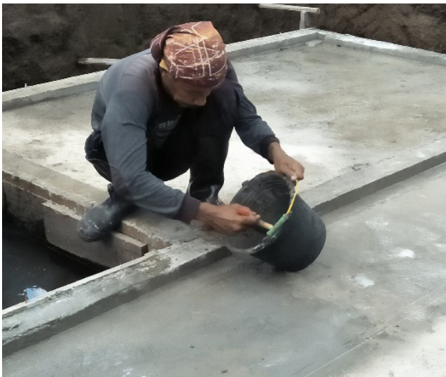
Gambar 38. Pengolesan bahan penolak air Sumber : Dok. BPCB DIY
