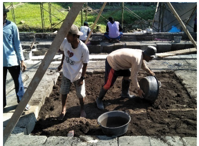
Gambar 30. Pemberian urugan pasir dan batu Sumber : Dok. BPCB DIY
