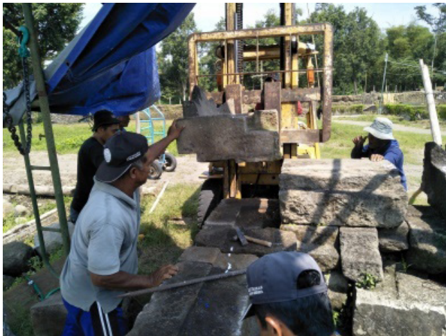
Gambar 28. Pembongkaran susunan percobaan Sumber : Dok. BPCB DIY
