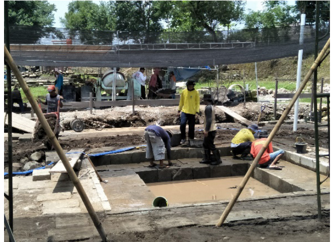
Gambar 36. Penyusunan batu sumuran (batu tuffa) Sumber : Dok. BPCB DIY
