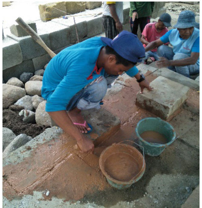
Gambar 37. Pengisian filler Sumber : Dok. BPCB DIY
