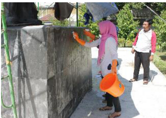
Gambar 17. Aplikasi HCl pada bagian pustek yang terkena leleran cat. (Foto: dok. BPCB DIY)
