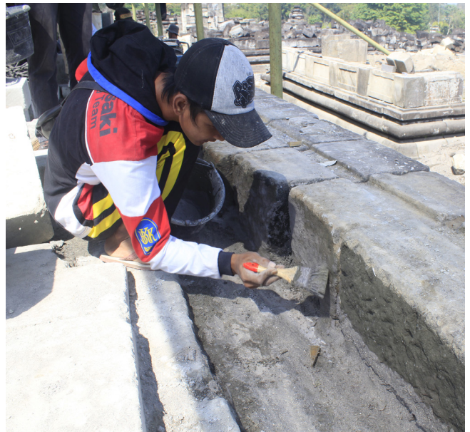
Gambar 29. Pengolesan lapisan kedap air pada permukaan dinding bagian dalam (Foto: dok. BPCB DIY)
