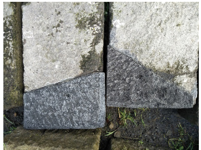
Gambar 22. Hasil Penyambungan batu Sumber : Dok. BPCB DIY
