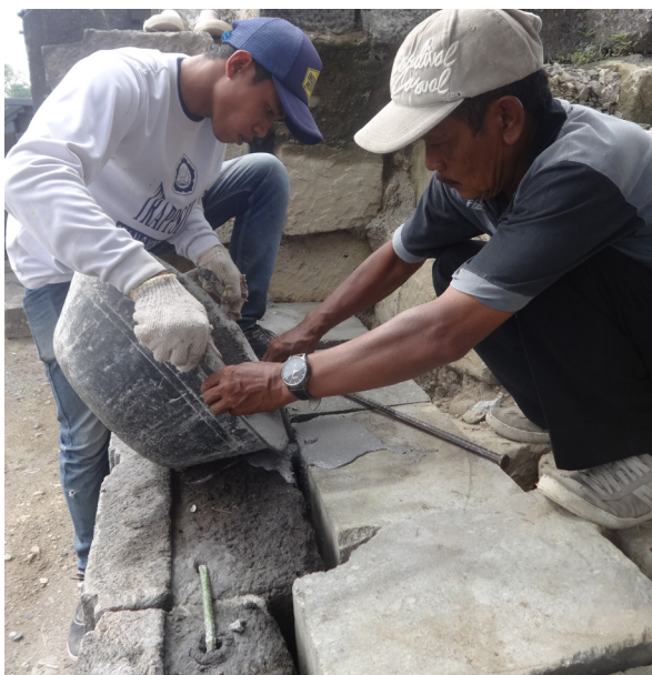
Gambar 19. Pengisian mortar hidrolik (Foto: dok. BPCB DIY)
