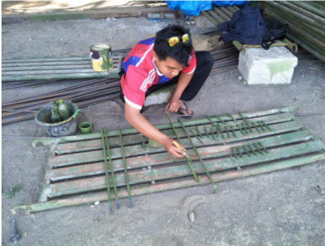
Gambar 19. pengolesan bahan anti karat Sumber : Dok. BPCB DIY
