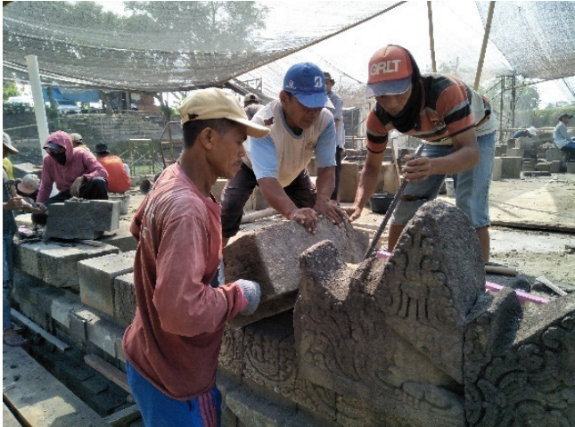
Gambar 34. Penyusunan kembali batu lapis 12 Sumber : Dok. BPCB DIY
