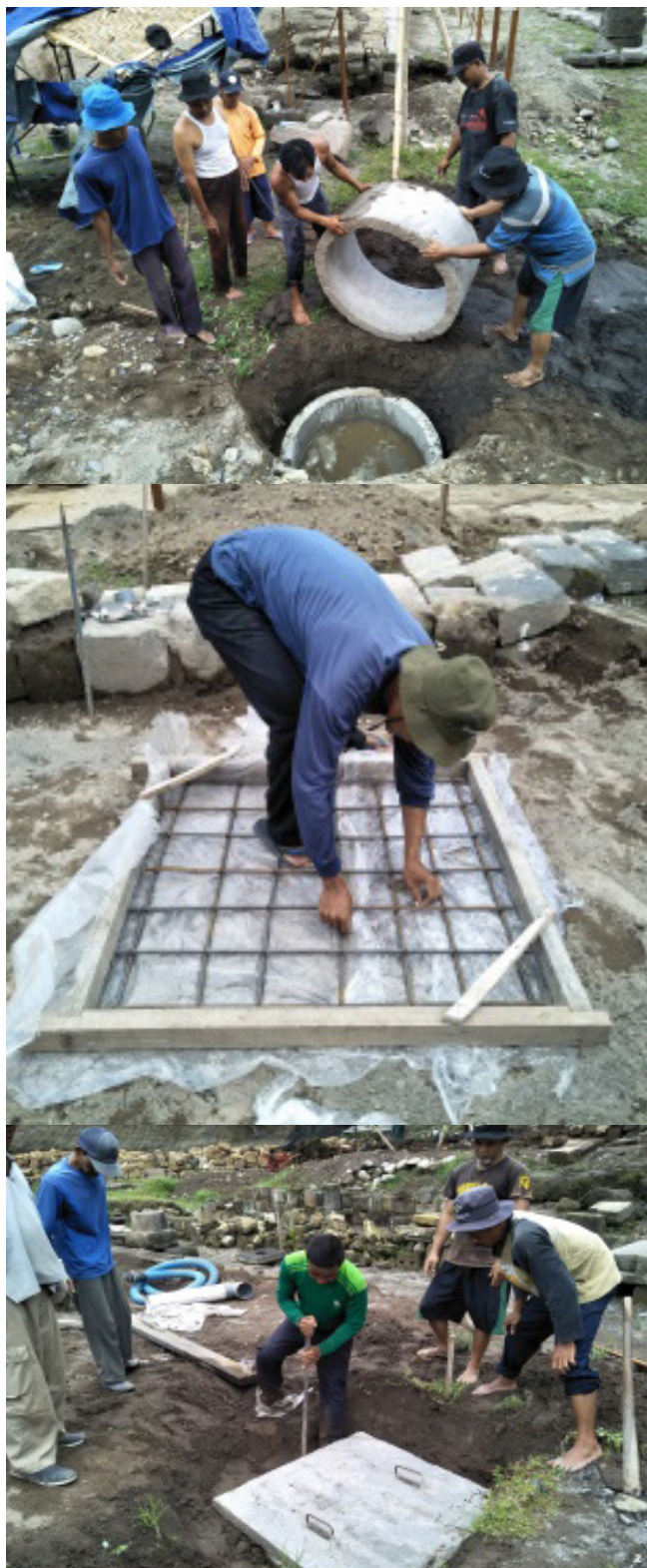
Gambar 40. Kegiatan pemasangan buis beton, pembuatan tutup bak kontrol dan pemasangan tutup bak kontrol Sumber : Dok. BPCB DIY
