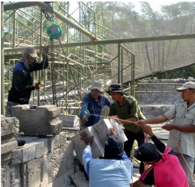
Gambar 35. Penyusunan kembali dinding luar lapis 6 sisi utara Sumber : Dok. BPCB DIY
