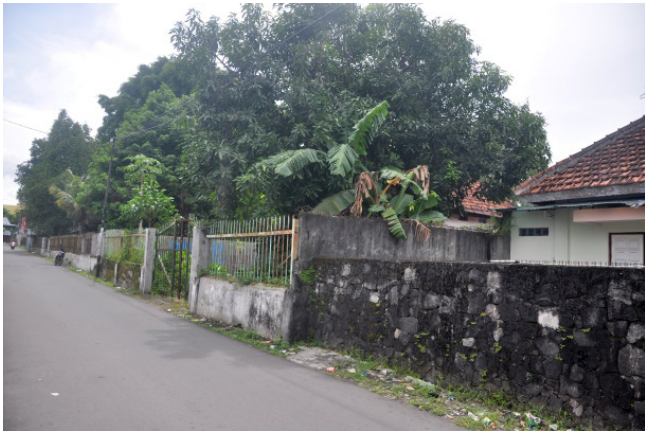
Kondisi pagar sisi barat yang sudah berhimpitan dengan rumah penduduk (Foto: dok. BPCB DIY)
