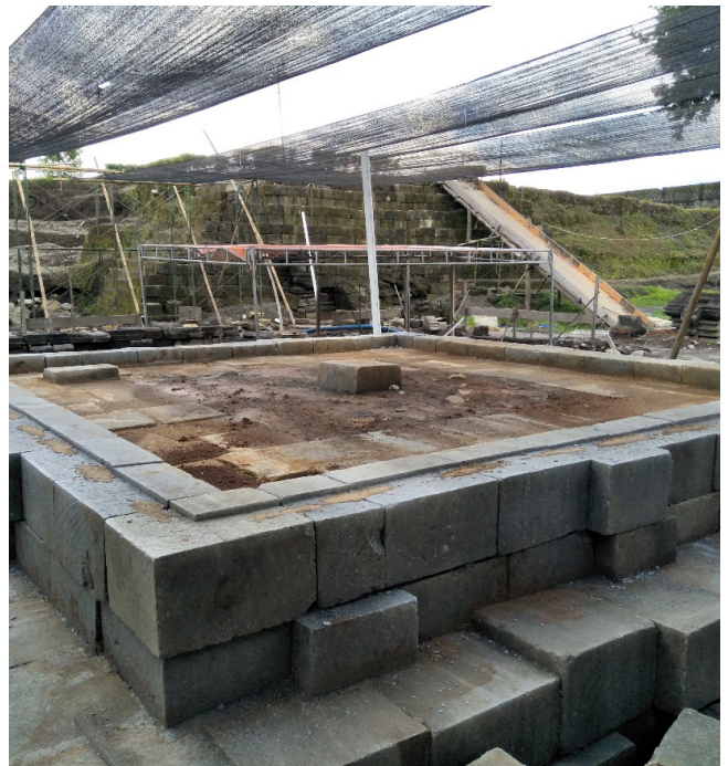
Gambar 9. Pemasangan deklit dan paranet Sumber : Dok. BPCB DIY
