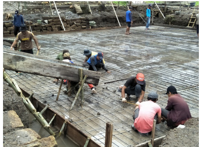
Gambar 29. pembuatan lantai kerja pondasi Sumber : Dok. BPCB DIY
