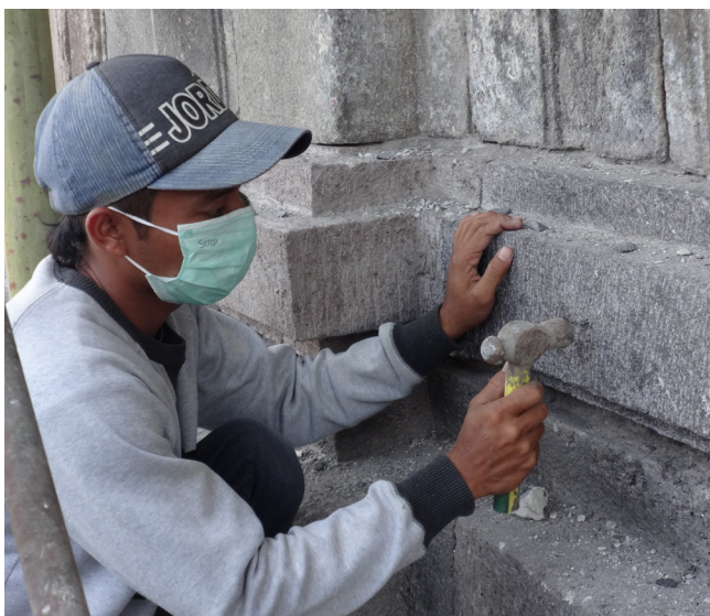
Gambar 24. Pemasangan tanda batu baru (Foto: dok. BPCB DIY)
