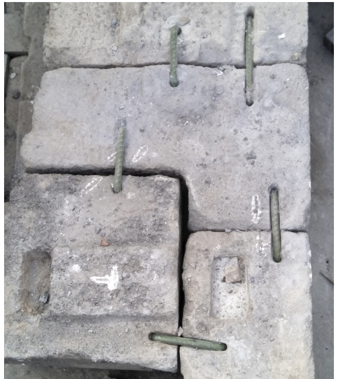
Gambar 18. Hasil pemasangan angkur
