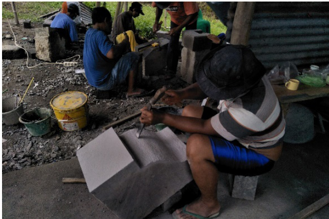
Gambar 23. Pembuatan batu pengganti Sumber : Dok. BPCB DIY
