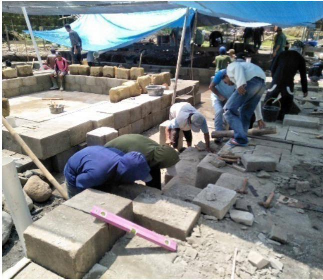
Gambar 31. Penyusunan isian blok batu tuff Sumber : Dok. BPCB DIY
