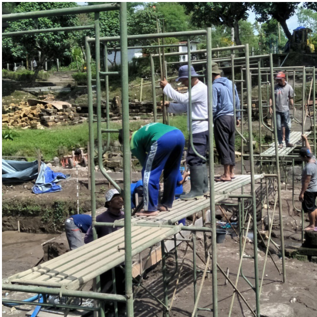
Gambar 10. Pemasangan perancah Sumber : Dok. BPCB DIY
