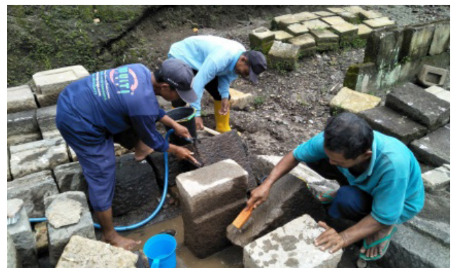
Gambar 15. Pembersihan mekanis Sumber : Dok. BPCB DIY
