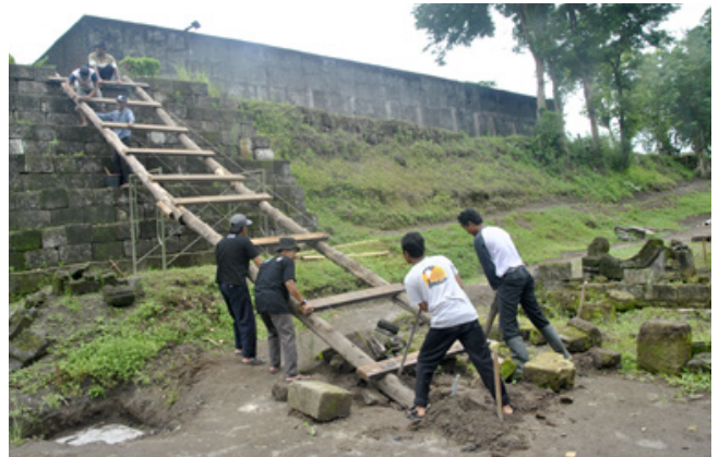
Gambar 5. Pembuatan jalan untuk menurunkan batu Sumber : Dok. BPCB DIY
