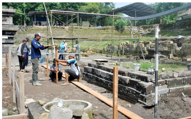
Gambar 7. Kegiatan pembuatan bouwplank . (Foto: Dok. BPCB DIY)
