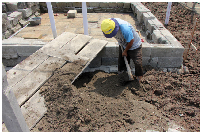
Gambar 27. Kegiatan pengurugan tanah kembali. (Foto: Dok. BPCB DIY)
