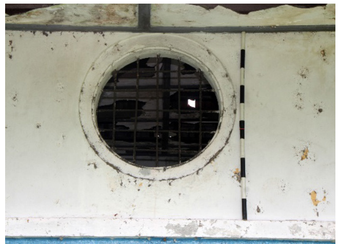
Gambar 7. Detail ventilasi berbentuk lingkaran dengan teralis besi. (Foto: Dok. BPCB DIY)
