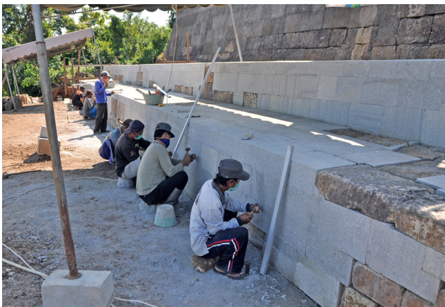
Gambar 18. Penyelarasan batu pengganti. (Foto: Dok. BPCB DIY)
