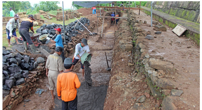
Gambar 11. Urugan pasir. (Foto: Dok. BPCB DIY)
