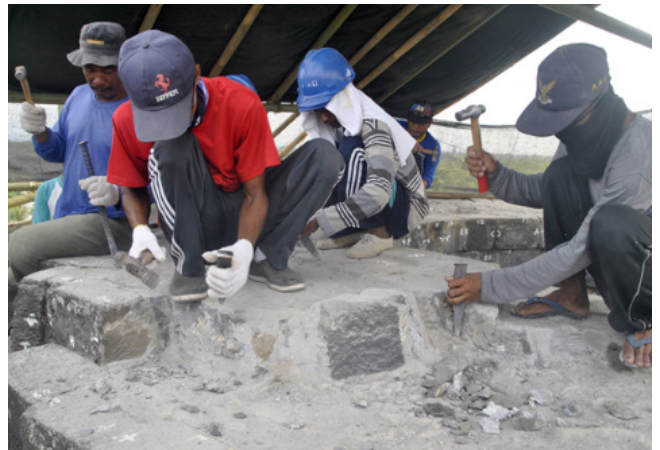
Gambar 27. Kegiatan pengikisan semen. (Foto: Dok. BPCB DIY)
