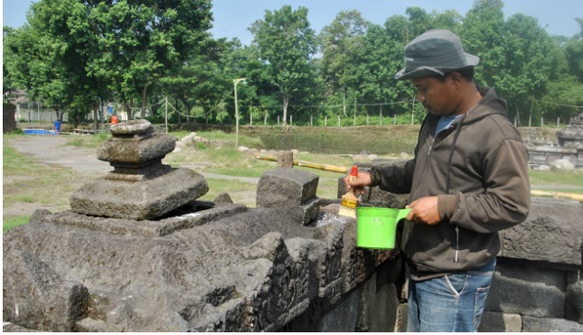
Gambar 16. Pengolesan AC322. (Foto: Dok. BPCB DIY)
