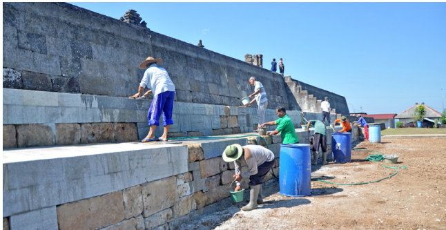
Gambar 20. Pembersihan mekanis seluruh bangunan. (Sumber: Dok. BPCB DIY)
