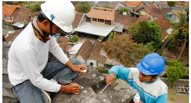
Gambar 14. Pemberian tanda pada batu ekspos di bagian atap. (Foto: Dok. BPCB DIY)
