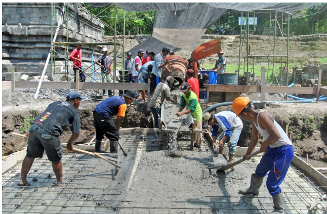
Gambar 25. Kegiatan pengecoran lantai kerja. (Foto: Dok. BPCB DIY)
