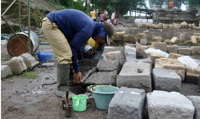
Gambar 17. Kegiatan penyambungan batu. (Foto: Dok. BPCB DIY)
