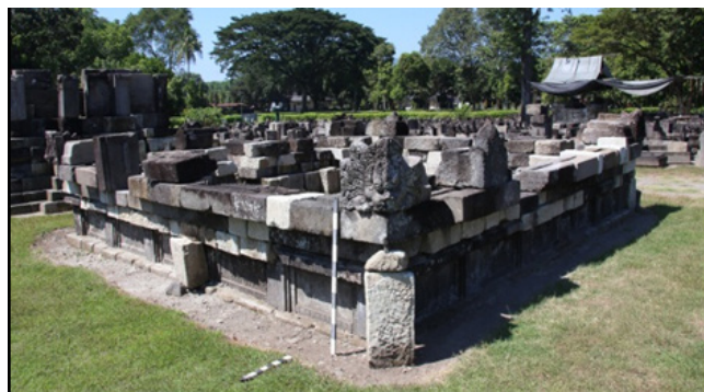
Gambar 11. Situasi hasil susun coba tubuh kaki Candi Perwara Deret I No.5. (Foto: Dok. BPCB DIY)
