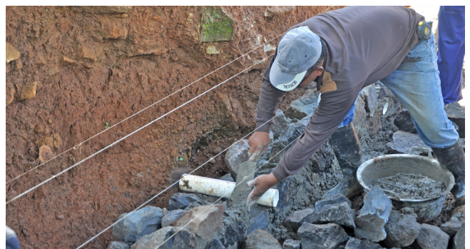
Gambar 12. Pemasangan suling-suling. (Foto: Dok. BPCB DIY)
