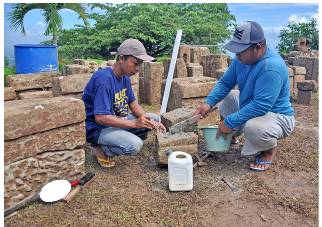
Gambar 9. Penyambungan batu. (Foto: Dok. BPCB DIY)
