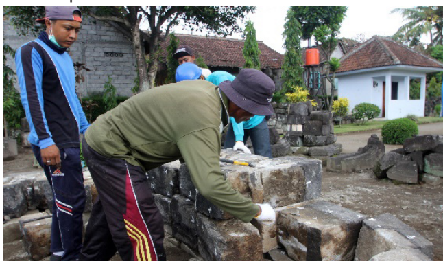
Gambar 24. Penyetelan dan penyusunan coba batuan sesuai posisinya di atap. (Foto: Dok. BPCB DIY)
