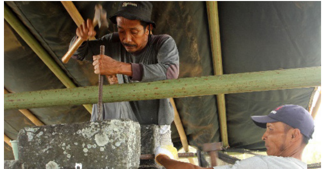
Gambar 19. Pemahatan batuan atap. (Foto: Dok. BPCB DIY)
