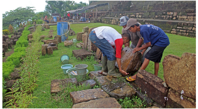
Gambar 6. Pembongkaran batu susun coba. (Foto: Dok. BPCB DIY)
