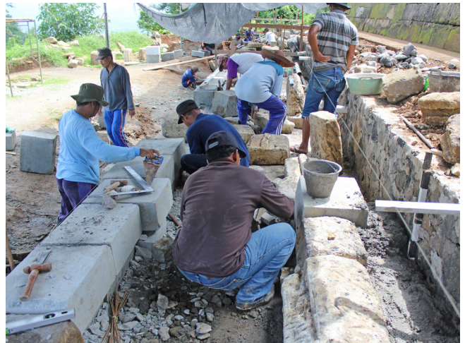
Gambar 16. Penyusunan kembali batu talud. (Foto: Dok. BPCB DIY)
