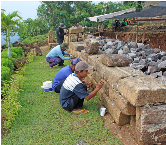
Gambar 5. Registrasi batu. (Foto: Dok. BPCB DIY)
