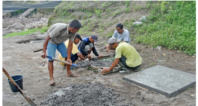
Gambar 32. Pembuatan bak kontrol. (Foto: Dok. BPCB DIY)
