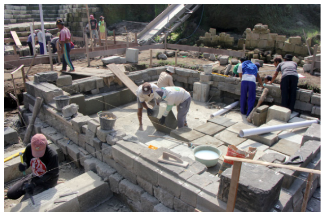
Gambar 30. Kegiatan pemasangan batu isian. (Foto: Dok. BPCB DIY)
