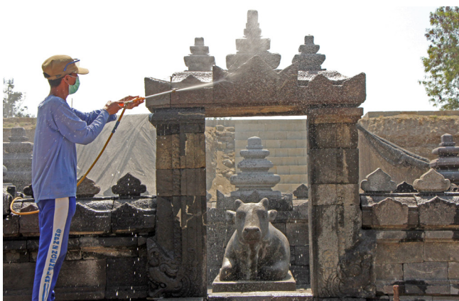
Gambar 34. Pembersihan mekanis basah setelah pemugaran selesai. (Foto: Dok. BPCB DIY)
