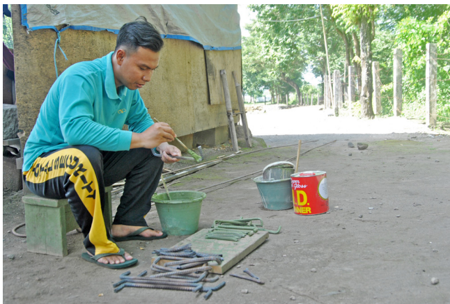
Gambar 20. Kegiatan pengolesan bahan anti karat. (Foto: Dok. BPCB DIY)
