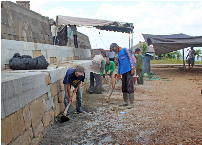
Gambar 17. Urugan tanah kembali. (Foto: Dok. BPCB DIY)
