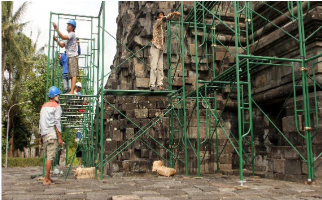
Gambar 26. Pemasangan perancah dengan pemberian alas kayu pada bagian kaki perancah. (Foto: Dok. BPCB DIY)
