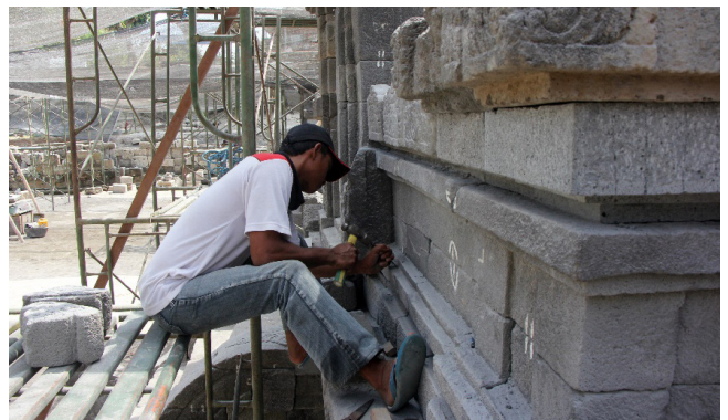
Gambar 33. Kegiatan penyelarasan batu baru. (Foto: Dok. BPCB DIY)
