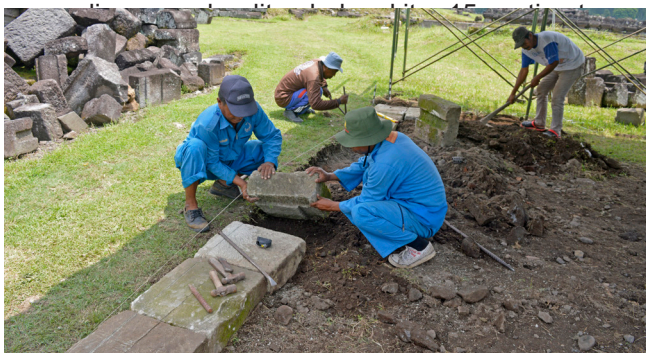
Gambar 3. Pembuatan landasan batu. (Foto: Dok. BPCB DIY)
