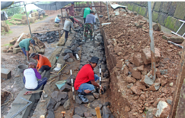
Gambar 13. Pemasangan pondasi batu kali belah. (Foto: Dok. BPCB DIY)
