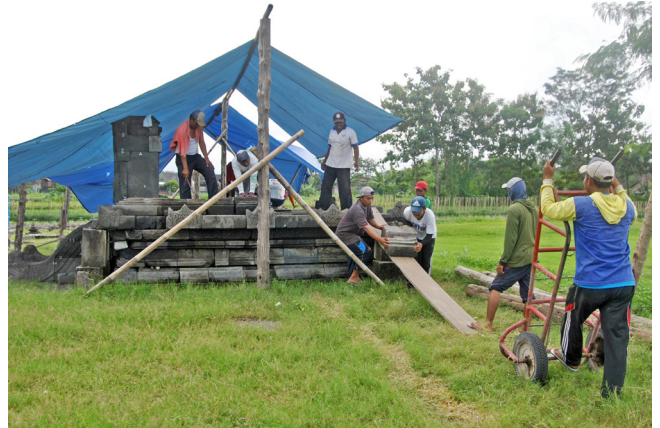
Gambar 24. Kegiatan pembongkaran susunan percobaan. (Foto: Dok. BPCB DIY)
