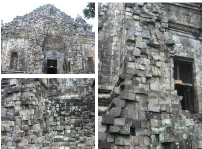
Gambar 1. Keruntuhan batuan pada bagian bangunan penampung menyebabkan sebagian batuan candi runtuh sehingga bilik candi terbuka dan menampilkan pola susunan batuan candi yang terekspos. (Foto: Dok. BPCB DIY)
