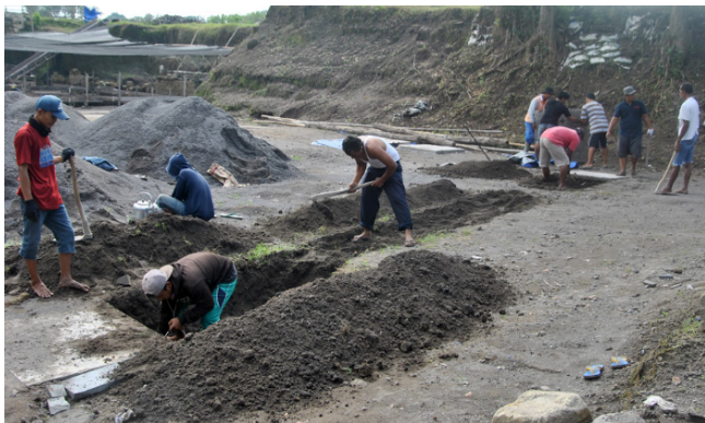
Gambar 31. Kegiatan penggalian tanah untuk saluran drainase. (Foto: Dok. BPCB DIY)
