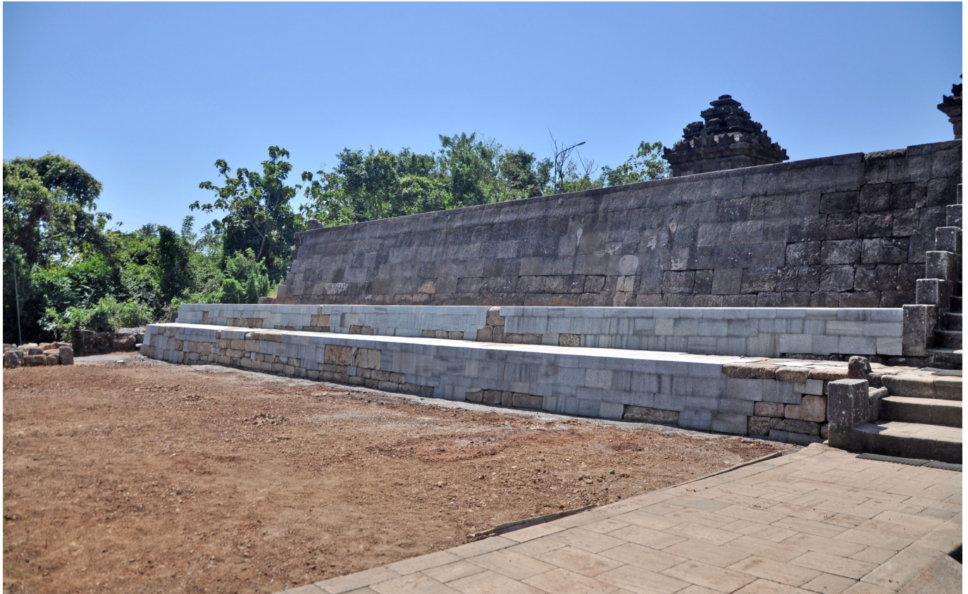
Gambar 24. Hasil pemugaran talud teras XI Candi Ijo tampak barat daya. (Sumber: Dok. BPCB DIY)
