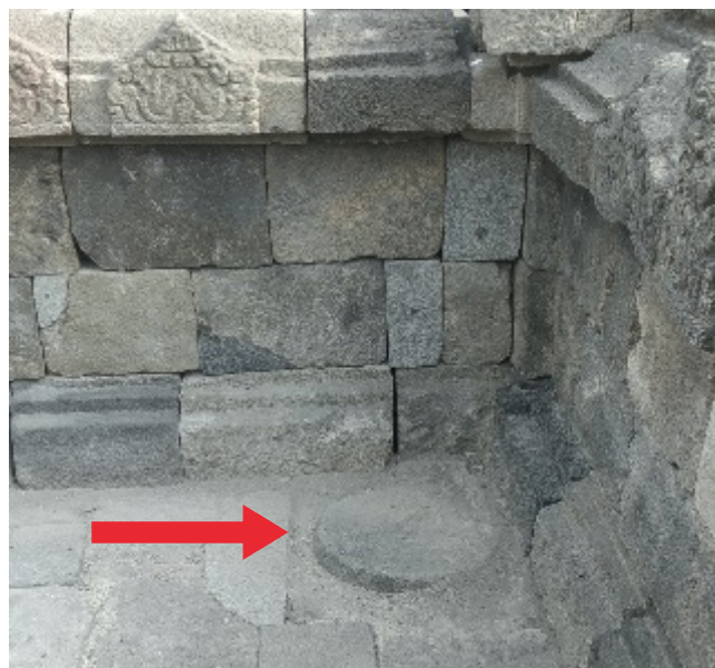
Gambar 2. Umpak pada Candi Perwara. (Foto: Dok. BPCB DIY)
