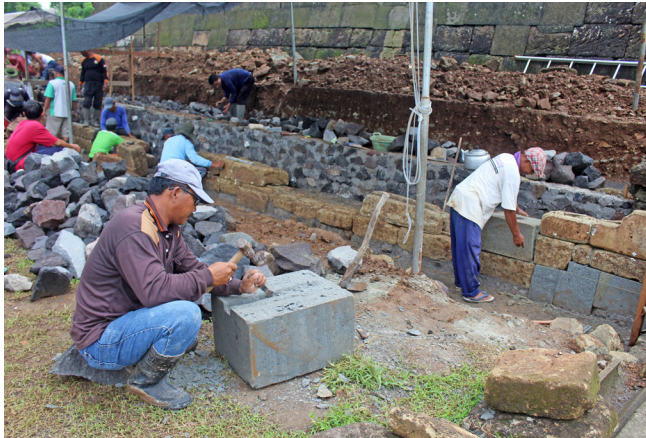
Gambar 9. Pembuatan batu pengganti dinding. (Foto: Dok. BPCB DIY)
