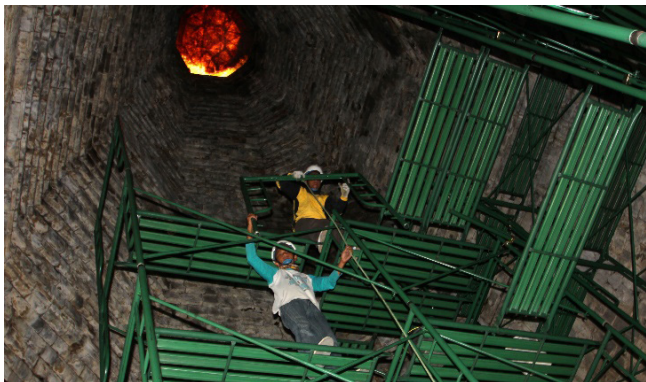
Gambar 13. Pemasangan Perancah di samping kiri dan kanan bilik. (Foto: Dok. BPCB DIY)
