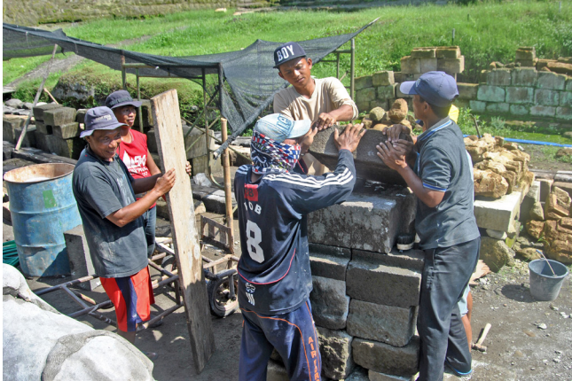
Gambar 22. Kegiatan susun coba (anastilosis). (Foto: Dok. BPCB DIY)
