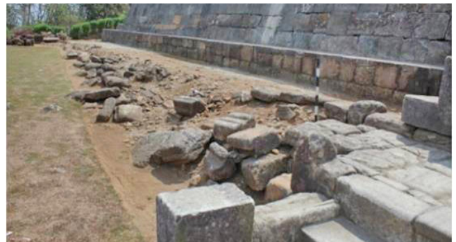
Gambar 1. Kondisi eksisting (dilihat dari barat daya). (Foto: Dok. BPCB DIY)
