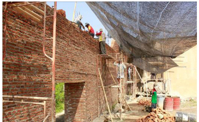
Gambar 12. Pemasangan struktur bata pada dinding sisi selatan. (Foto: Dok. BPCB DIY)
