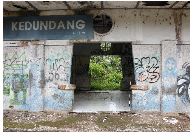
Gambar 5. Situasi di dalam ruang tunggu, tampak pintu terbuka di sisi utara dan selatan. (Foto: Dok. BPCB DIY)
