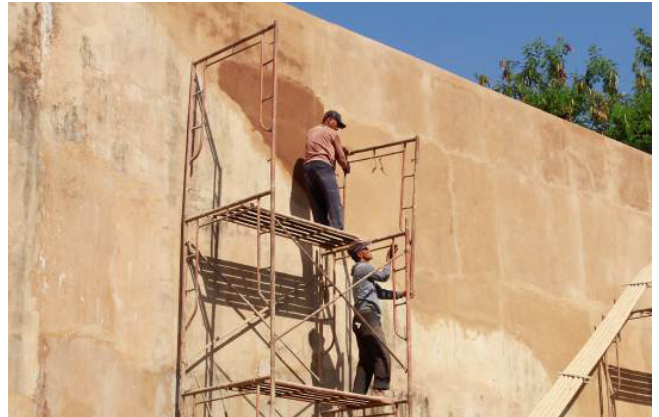
Gambar 4. Proses pemasangan perancah pada dinding sisi timur. (Foto: Dok. BPCB DIY)
