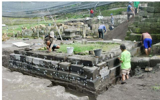
Gambar 10. Kegiatan registrasi batu insitu. (Foto: Dok. BPCB DIY)
