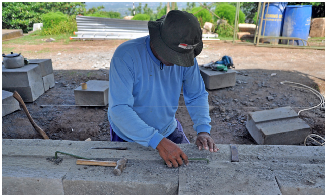
Gambar 8. Pemasangan hak pada struktur talud. (Foto: Dok. BPCB DIY)
