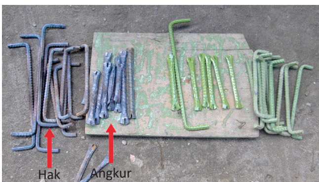
Gambar 21. Hasil pengolesan bahan anti karat pada hak dan angkur. (Foto: Dok. BPCB DIY)
