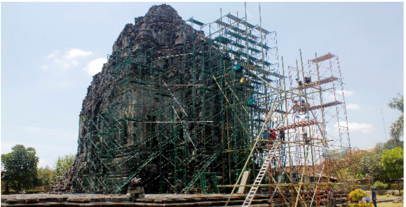
Gambar 12. Pemasangan Perancah sisi utara candi. (Foto: Dok. BPCB DIY)
