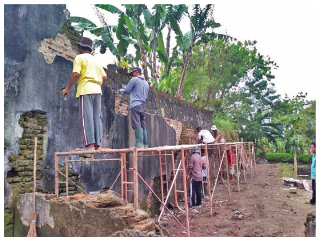
Gambar 5. Kegiatan pengupasan pada dinding sisi timur. (Foto: Dok. BPCB DIY)
