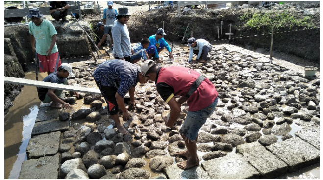
Gambar 26. Kegiatan pengurugan batu boulder. (Foto: Dok. BPCB DIY)
