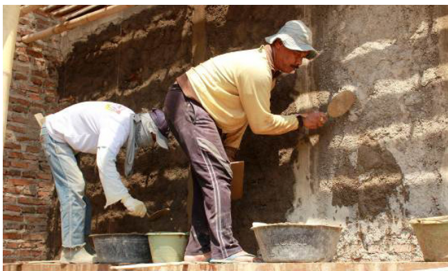
Gambar 14. Pemasangan plesteran pada dinding sisi selatan. (Foto: Dok. BPCB DIY)
