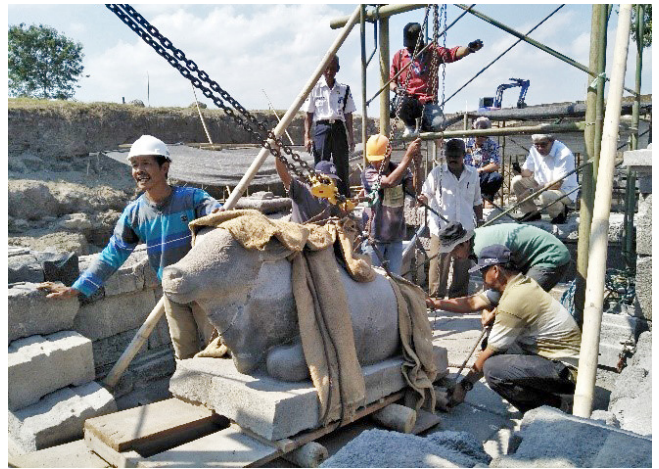
Gambar 29. Pemasangan kembali arca Nandi pada Candi Perwara tengah. (Foto: Dok. BPCB DIY)
