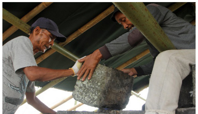
Gambar 20. Pembongkaran batu. (Foto: Dok. BPCB DIY)
