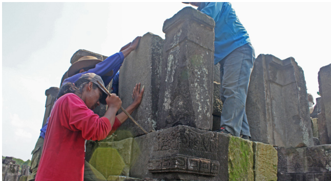
Gambar 6. Kegiatan susun coba bagian tubuh. (Foto: Dok. BPCB DIY)
