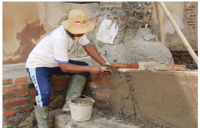
Gambar 15. Pemasangan plesteran trasraam pada kolam naga sisi timur. (Foto: Dok. BPCB DIY)
