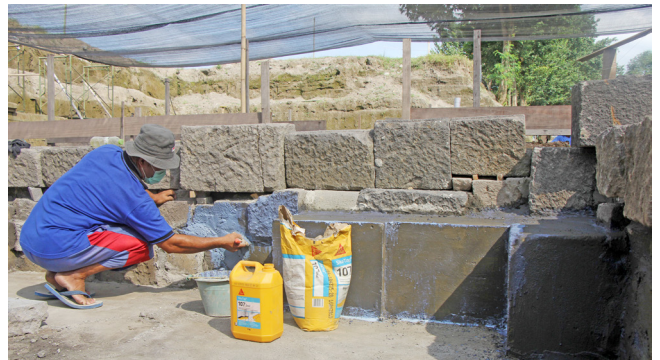
Gambar 18. Kegiatan pengolesan bahan kedap air. (Foto: Dok. BPCB DIY)
