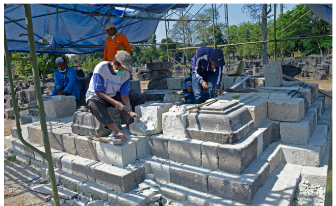
Gambar 8. Kegiatan pembuatan batu pengganti sementara Candi Perwara Deret I No. 5. (Foto: Dok. BPCB DIY)
