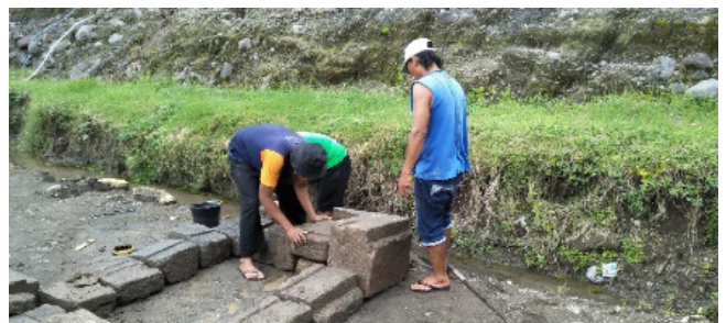
Gambar 13. Kegiatan pengelompokan batu hasil pembongkaran. (Foto: Dok. BPCB DIY)
