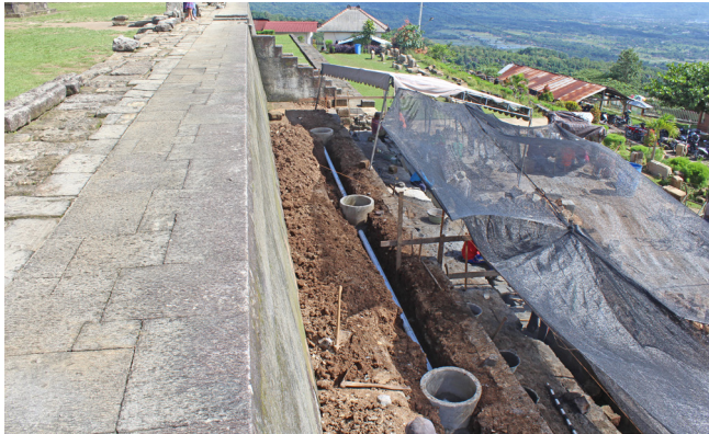
Gambar 15. Pembuatan drainase, tampak atas dilihat dari utara. (Foto: Dok. BPCB DIY)
