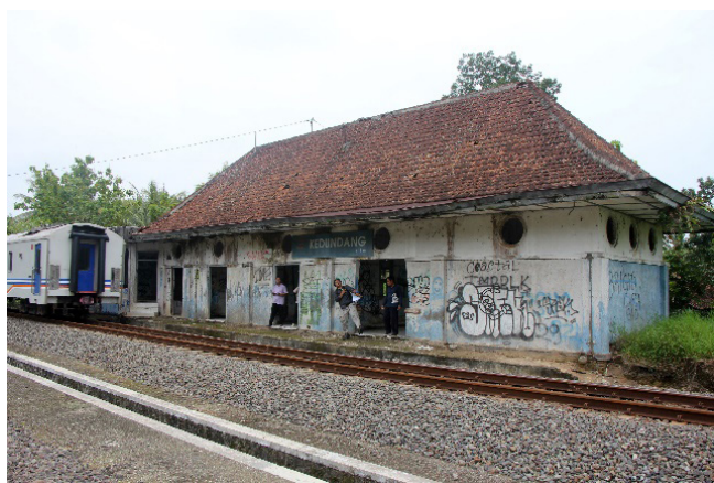
Gambar 12. Atap limasan pada bangunan Stasiun Kedundang, tampak dari arah barat laut. (Foto: Dok. BPCB DIY)
