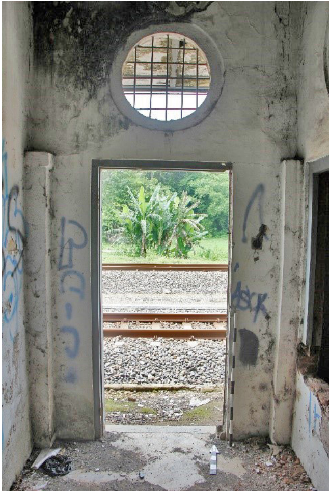
Gambar 10. Ruangan paling timur Stasiun Kedundang digunakan untuk gudang. (Foto: Dok. BPCB DIY)
