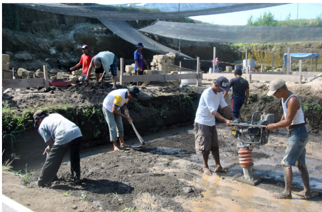
Gambar 28. Foto kegiatan pemadatan tanah. (Foto: Dok. BPCB DIY)
