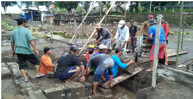
Gambar 11. Kegiatan pembongkaran batu insitu. (Foto: Dok. BPCB DIY)
