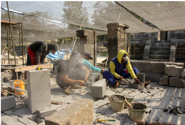
Gambar 23. Kegiatan pembuatan batu pengganti. (Foto: Dok. BPCB DIY)
