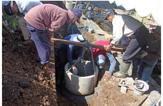
Gambar 14. Pemasangan buis beton. (Foto: Dok. BPCB DIY)
