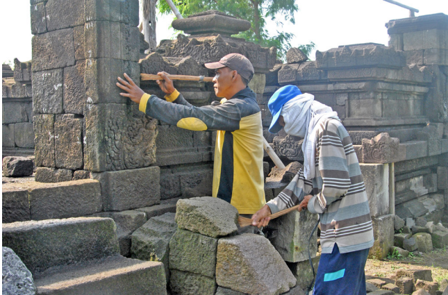
Gambar 14. Kegiatan pembersihan mekanis kering. (Foto: Dok. BPCB DIY)
