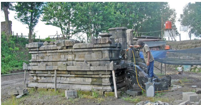
Gambar 15. kegiatan pembersihan mekanis basah. (Foto: Dok. BPCB DIY)
