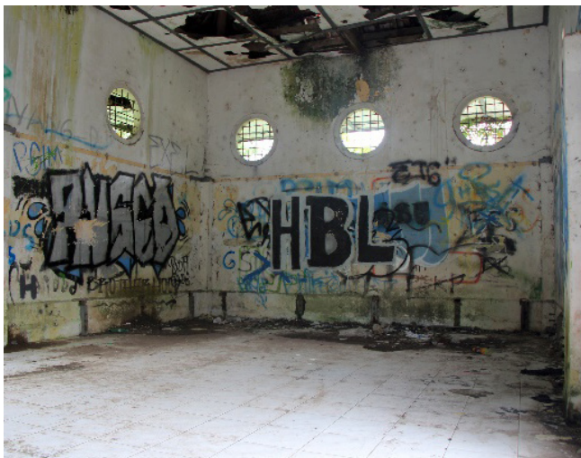
Gambar 4. Situasi ruang tunggu dan pintu terbuka di sisi utara serta ventilasi. (Foto: Dok. BPCB DIY)
