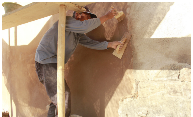
Gambar 16. Pengacian dinding benteng sisi selatan. (Foto: Dok. BPCB DIY)
