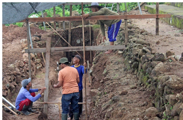
Gambar 4. Pemasangan bouwplank . (Foto: Dok. BPCB DIY)
