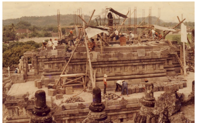
Perkuatan Dinding Beton Pada Candi Brahma Tahun 1985. (Sumber: Arsip BPCB DIY)
