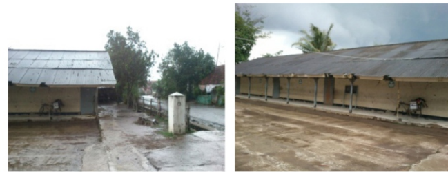
Gambar 2. Kondisi area halaman yang ditembok
