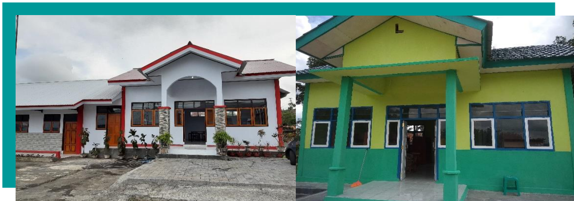
Gambar 3.7. Pembangunan Ruang Perpustakaan
