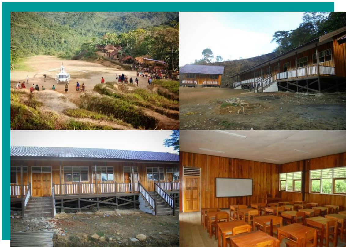
Gambar 3.2. Pembangunan Unit Sekolah Baru
