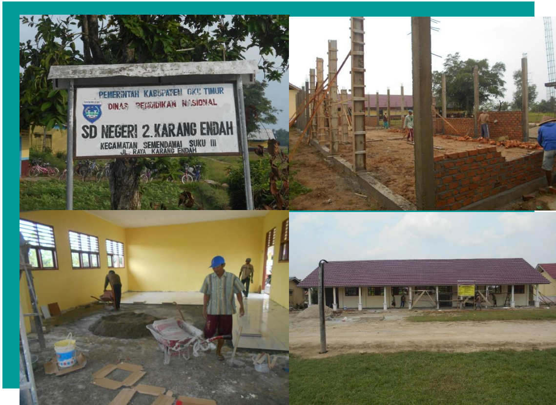
Gambar 3.1. Pembangunan Ruang Kelas Baru
