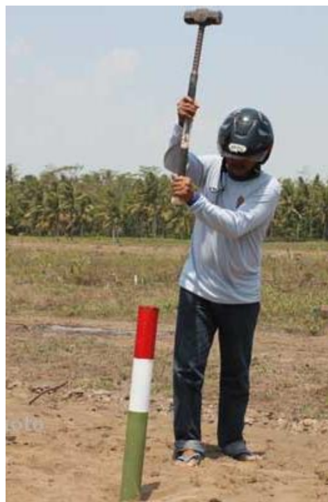
Gambar 14. Pemasangan Patok sementara
