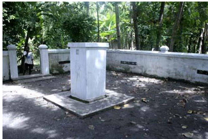
Gambar 16. Patok beton triangulasi
