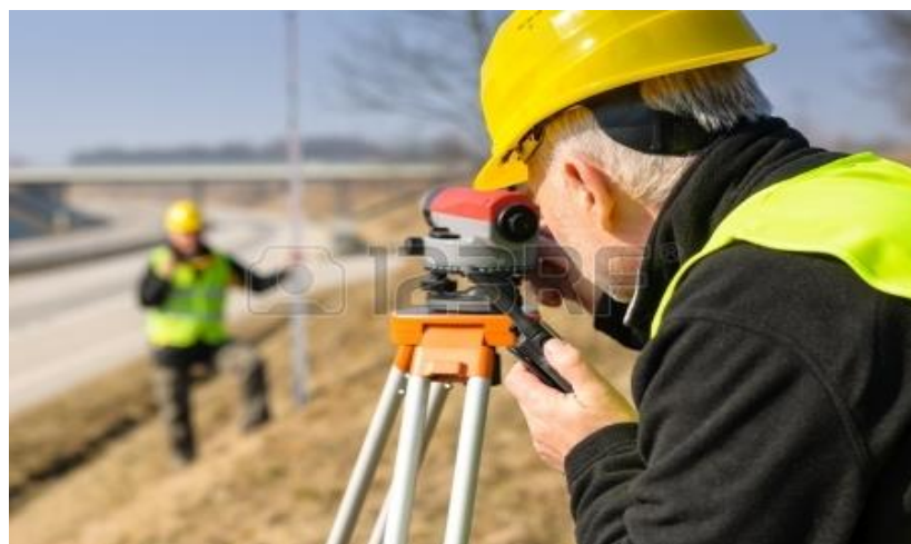
Gambar 142. Pengukuran jarak dengan penyipat datar
