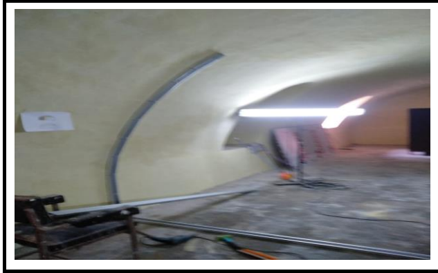
FOTO KEGIATAN PEMASANGAN RANGKA CANAL C PARTISI RUANG LANTAI I
