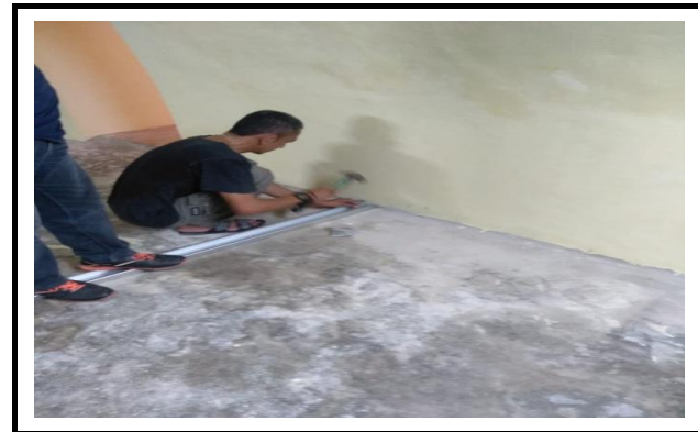
FOTO KEGIATAN PEMBUATAN BAGIAN RANGKA DAN PEMASANGAN RANGKA PARTISI
