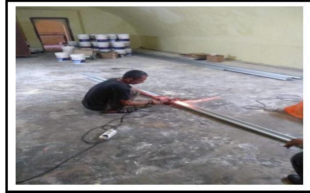
FOTO KEGIATAN PEMBUATAN BAGIAN RANGKA DAN PEMASANGAN RANGKA PARTISI
