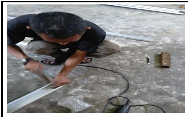
FOTO KEGIATAN PEMBUATAN BAGIAN RANGKA DAN PEMASANGAN RANGKA PARTISI
