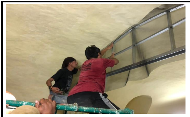
FOTO KEGIATAN PEMASANGAN RANG BAGIAN ATAS PARTISI LANTAI I
