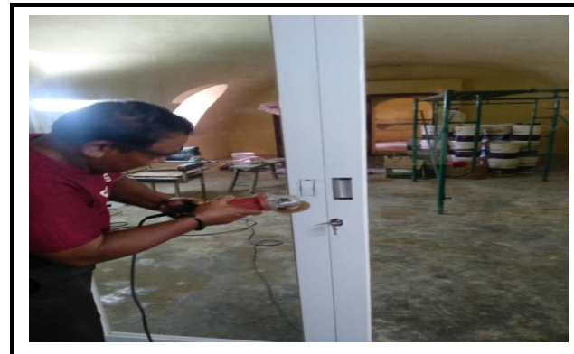
FOTO; KEGIATAN PEMBUATAN RANGKA PINTU GESER BAHAN ALUMINIUM 3/6 DAN PEMASANGAN PINTU
