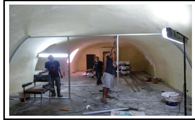
FOTO KEGIATAN PEMASANGAN RANGKA CANAL C PARTISI RUANG LANTAI I
