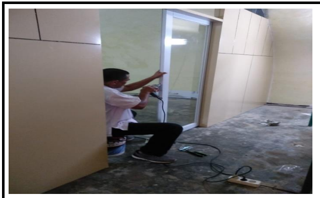
FOTO; KEGIATAN PEMBUATAN RANGKA PINTU GESER BAHAN ALUMINIUM 3/6 DAN PEMASANGAN PINTU
