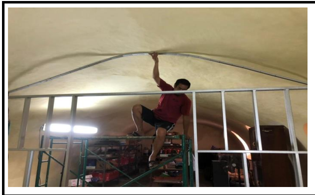
FOTO KEGITAN PEMASANGAN RANGKA HOLLO BAGIAN ATAS 100%
