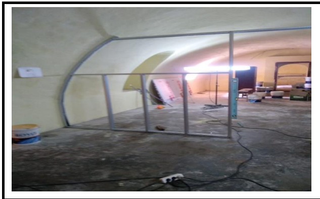
FOTO KEGIATAN PEMASANGAN RANGKA CANAL C PARTISI RUANG LANTAI I
