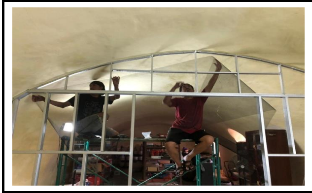
FOTO KEGIATAN PEMASANGAN RANG BAGIAN ATAS PARTISI LANTAI I
