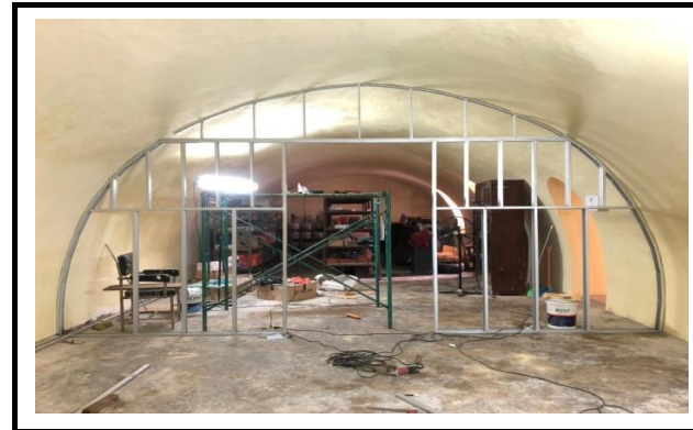
FOTO KEGITAN PEMASANGAN RANGKA HOLLO BAGIAN ATAS 100%
