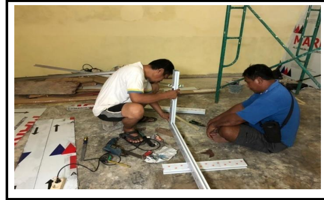
FOTO; KEGIATAN PEMBUATAN RANGKA PINTU GESER BAHAN ALUMINIUM 3/6 DAN PEMASANGAN PINTU
