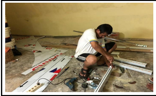
FOTO; KEGIATAN PEMBUATAN RANGKA PINTU GESER BAHAN ALUMINIUM 3/6 DAN PEMASANGAN PINTU
