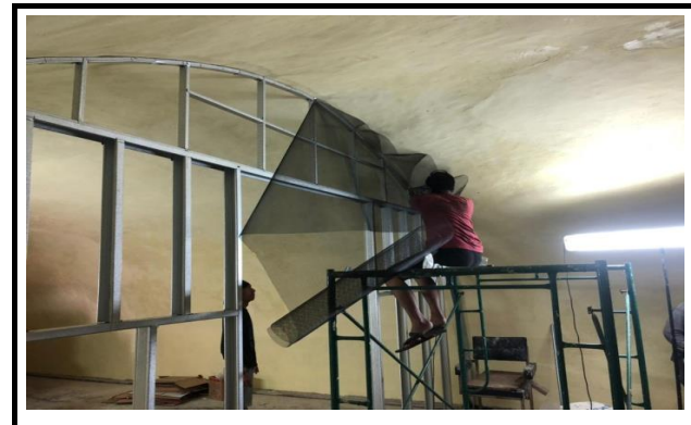
FOTO KEGIATAN PEMASANGAN RANG BAGIAN ATAS PARTISI LANTAI I
