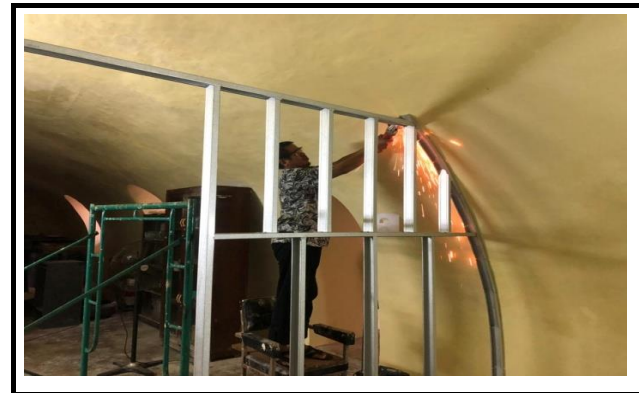
FOTO KEGIATAN PEMASANGAN RANGKA CANAL C PARTISI RUANG LANTAI I
