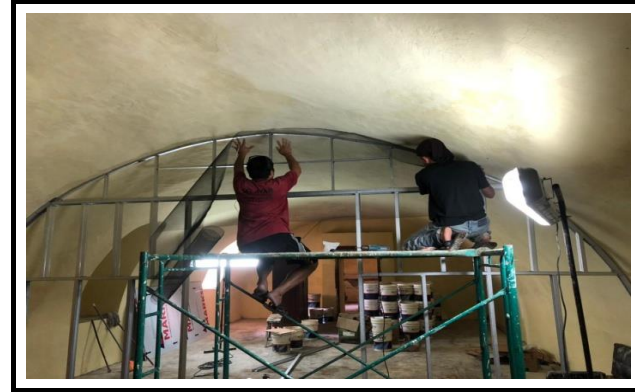
FOTO KEGIATAN PEMASANGAN RANG BAGIAN ATAS PARTISI LANTAI I
