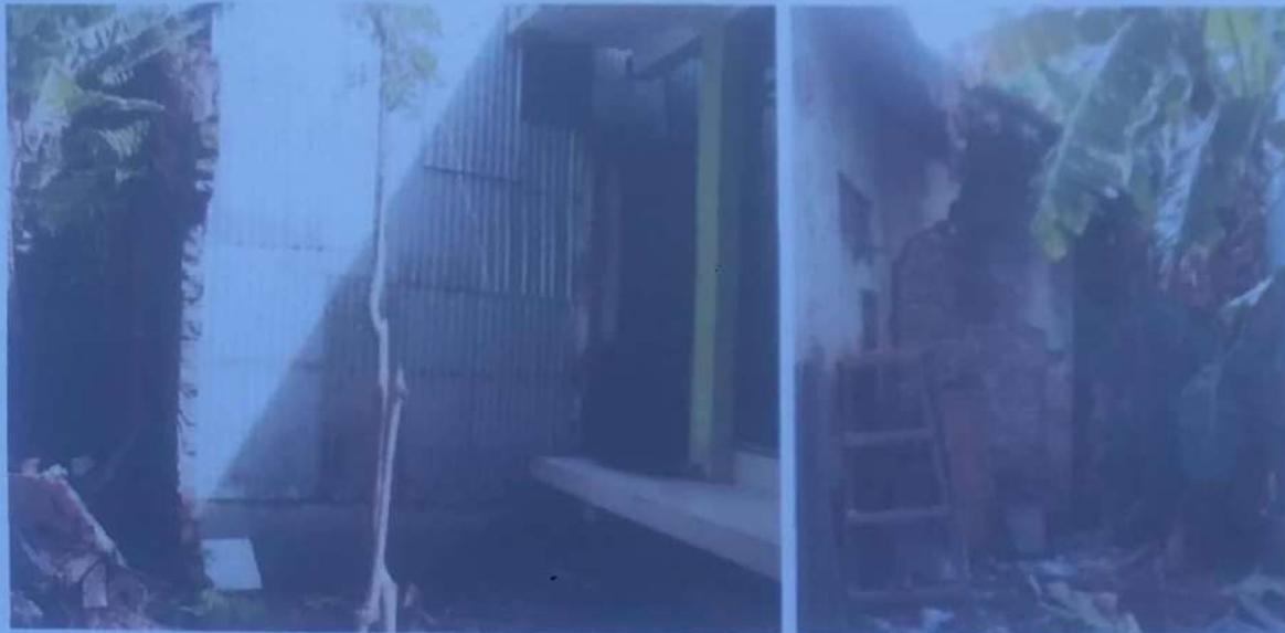
Sisi belakang Barat Laut & Timur Laut bangunan no 3
