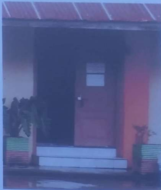
Penambahan kenaikan level lantai bangunan no 4 dan no 2
