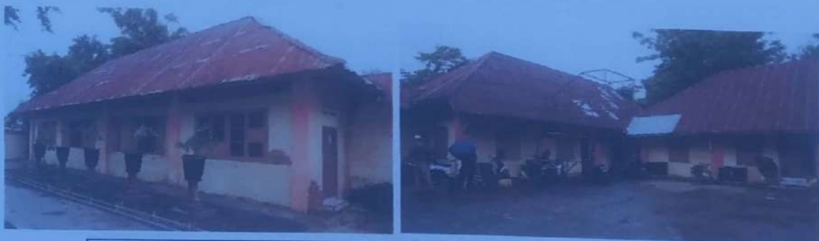
Bangunan no 2.1 tampak sisi selatan-utara dan bangunan 2.2 sisi timur
