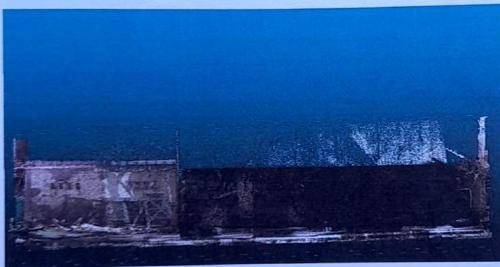
Tampak belakang (sisi utara)
