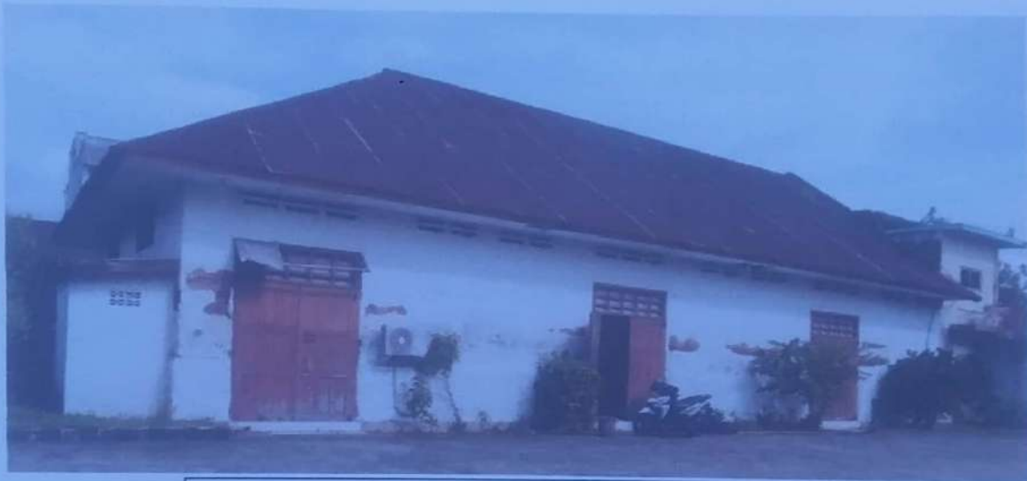
Tampak sisi barat bangunan utama (aula) Bekas Sekolah Tionghoa
