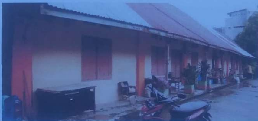
Bangunan no 2.2 tampak sisi timur
