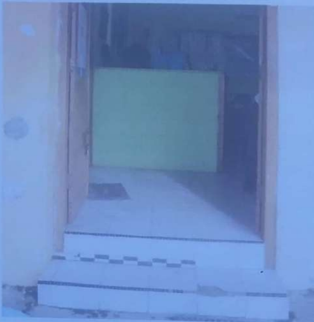
Penambahan kenaikan level lantai bangunan no 4 dan no 2
