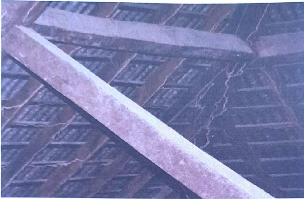
Jalur rayap pada rangka atap bangunan nomor 4
