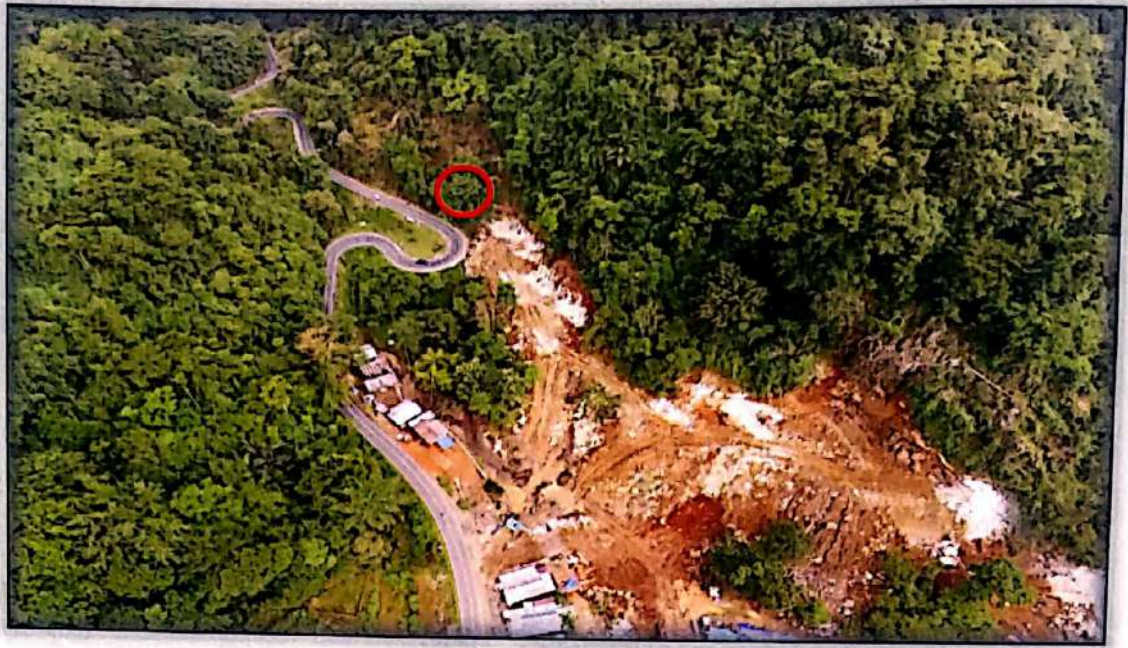
Gambar 1. Foto lokasi permanen Bunker 1 (ringkasan) di jalur perantara jalan layang (elevated road) Segmen 1 di Kampung Pattunung Aue, diarahkan dari utara ke selatan sepanjang (Sudut Foto dan Urutan Foto) Diklat PT. Wa
