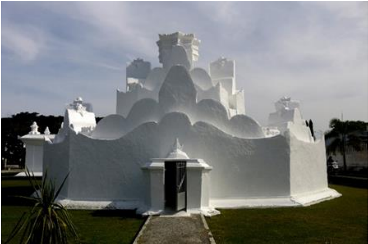
Gambar 1. Tampak depan Gunongan (Dokumentasi Andri Restiyadi 2017)
