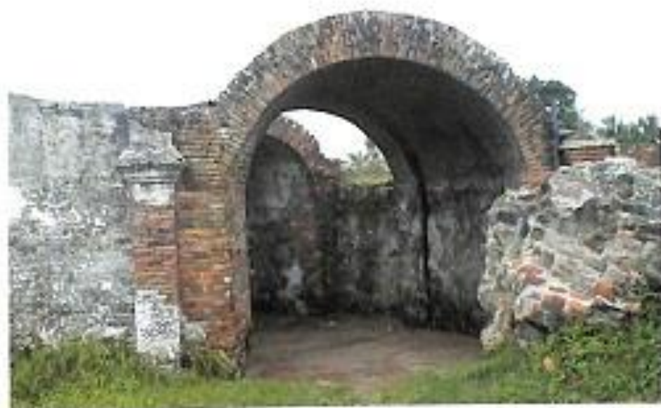
Pintu Gerbang Keraton Surusowan Bagian Timur
