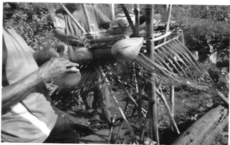
Gambar 8: Kalembungo dipasang pada keempat sudut pondok dan satu buah pada tingkatan teratas.
