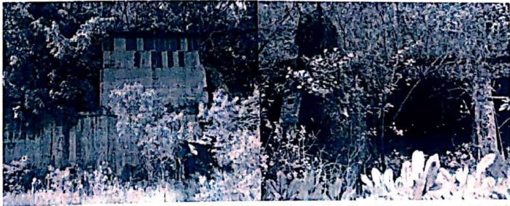
Bangunan raksasa menyerupai teras-teras beton (kiri), dan bagian dalam bangunan besar (kiri) (Koleksi : BP3 Makassar 2011)
