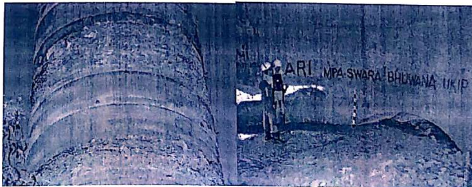
Detail sambungan berbentuk cincin beton pada bangunan cerobong (kiri), dan kondisi bagian dalam cerobong (kanan) (Koleksi : BP3 Makassar 2011)
