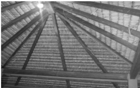
Setelah semua anyaman *re* terpasang, bagian lain dari atap Berugaq adalah menutup bagian pertemuan keempat sisi atap serta bagian ujung atasnya. Jika menggunakan *re*, titik-titik pertemuan atap ditutup juga dengan anyaman *re* yang dibuat memanjang ke bawah.
