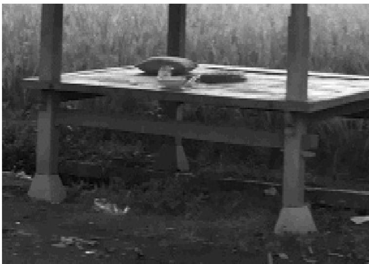
Dua buah *perteng* ditempatkan pada sisi kiri dan kanan atau samping. Dua buah balok kayu ini juga dipasak. Dua balok kayu ini juga dimasukkan ke dalam lubang yang telah di buat pada keempat tiang Berugaq. Posisinya tepat berada di atas *jejait*.
