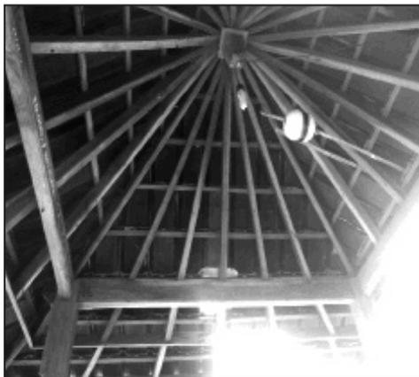
Bagian ujung atas keempat tiang *secepat* telah dilubangi. Bagian ujung kedua sisi balok-balok juga dikesilkan. Pengecilan ini mengikuti pola pemahatan ujung *jejit* dan *perteng*. Keempat ujung balok tersebut dibuatkan motif pada bagian yang tersisa atau menonjol keluar sekitar 20 sentimeter. Proses pengecilan menggunakan pahat.
