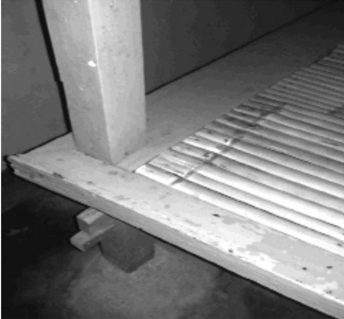
Keempat sisi alas dipasang balok kayu tipis. Keempat balok tersebut tidak dipasang rata dengan balok yang ada di atas *perteng*. Terdapat sisa sesuai dengan tebal papan yang akan dipasang.
