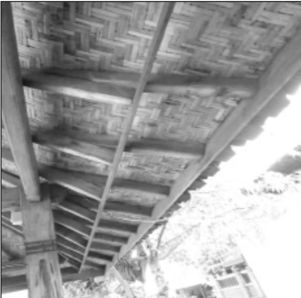
Penambahan ini membuat atap Berugaq tidak turun lurus membentuk garis diagonal ke bawah. Atap bagian bawah seperti sedikit meliuk. Model atap seperti ini membuat air hujan tidak terlalu deras turun ke bawah. Pada ujung usuk tambahan juga terdapat papan panjang. Papan tersebut dipasang rata pada sisi atasnya dengan ujung atas usuk.
