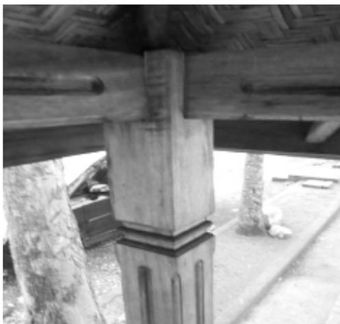
Dua balok pada sisi depan dan belakang memiliki pahatan yang lebih dalam dibandingkan dengan dua balok yang dipasang pada sisi kiri dan kanan. Hal ini dimaksudkan supaya ketika dipasang ujung atasnya rata dengan keempat ujung tiang *secepat*.
