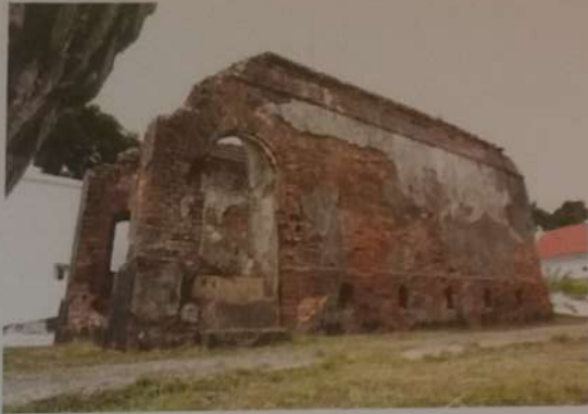
Foto 3. Struktur H Benteng Balangnipa (Dokumentasi BPCB Sul-Sel)
