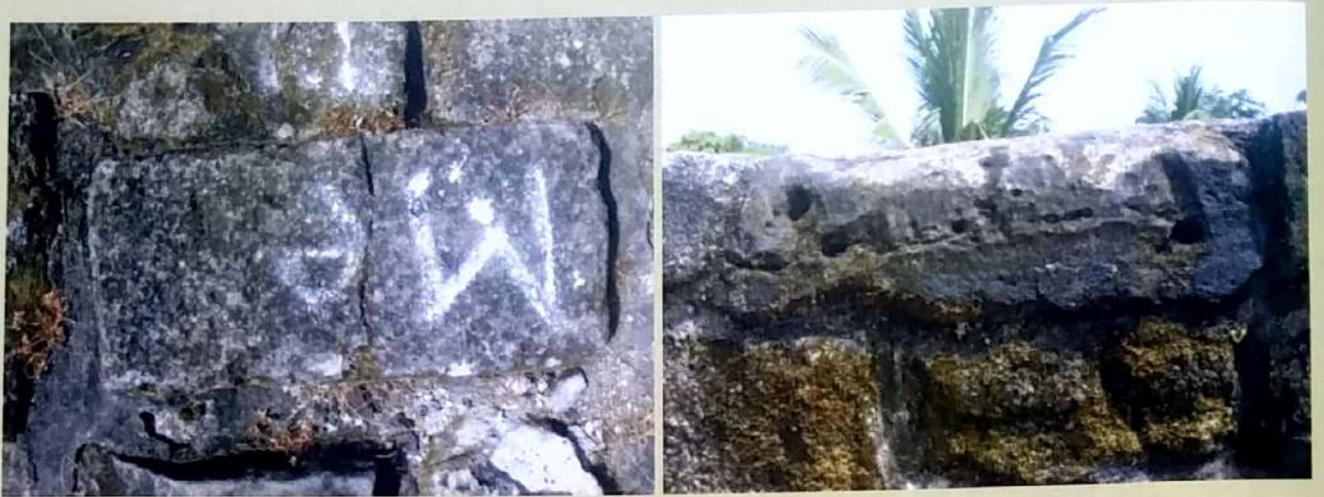
Foto 35, 36 Keadaan batu benteng yang pecah, retak dan patah.
