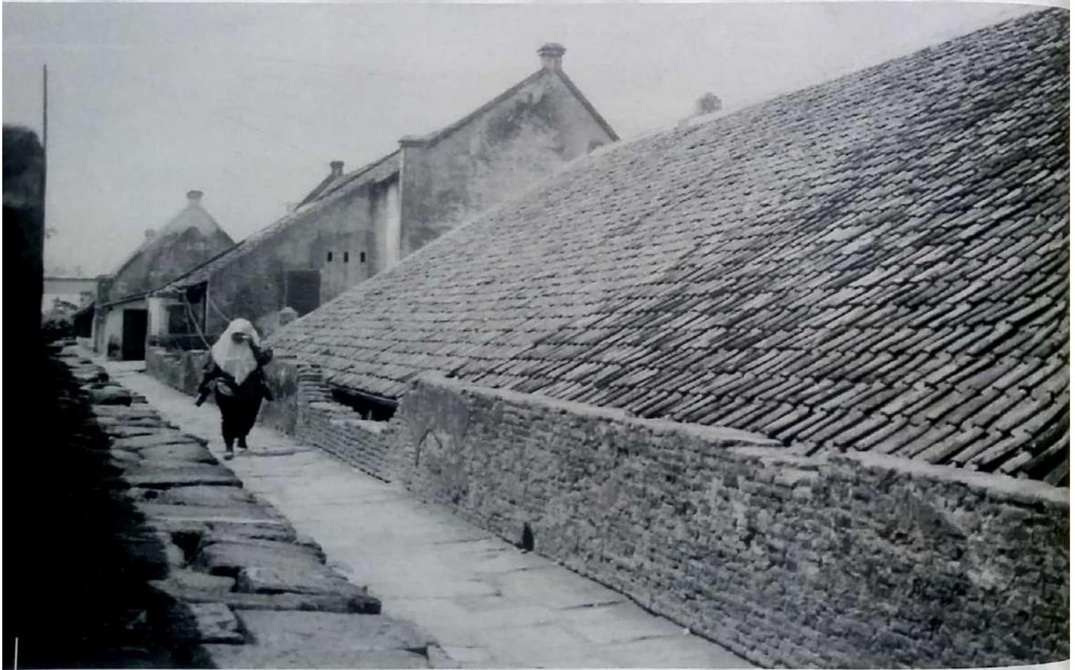
Foto 11: Dinding benteng sangat tebal, bagian atasnya ada koridor, cukup lebar untuk patroli keliling benteng, dinding sisi timur atau belakang
