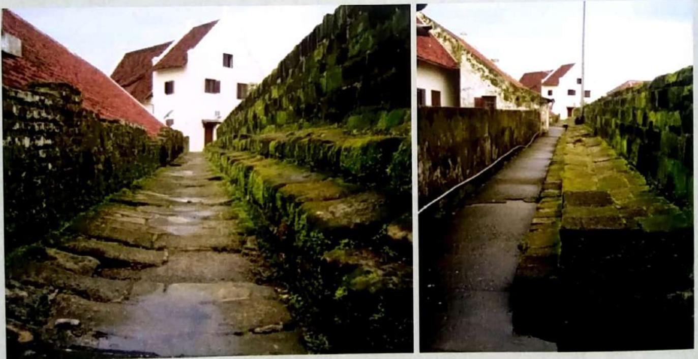
Foto 40, 41 : Lumut pada dinding bangunan dan dinding benteng
