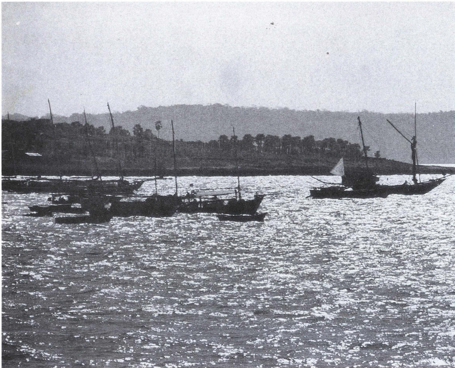
Perahu-perahu nelayan yang sedang berlabuh di pantai.
