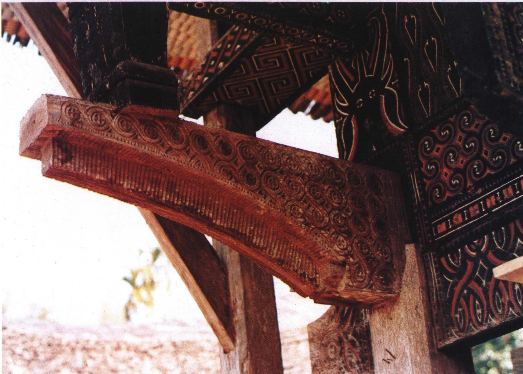
Konstruksi kayu Panggosokan Tingayo dan Pallo' (terletak pada bagian muka dan belakang dari Tongkonan) yang tertopang pada lentong garopang atau tiang utama.
