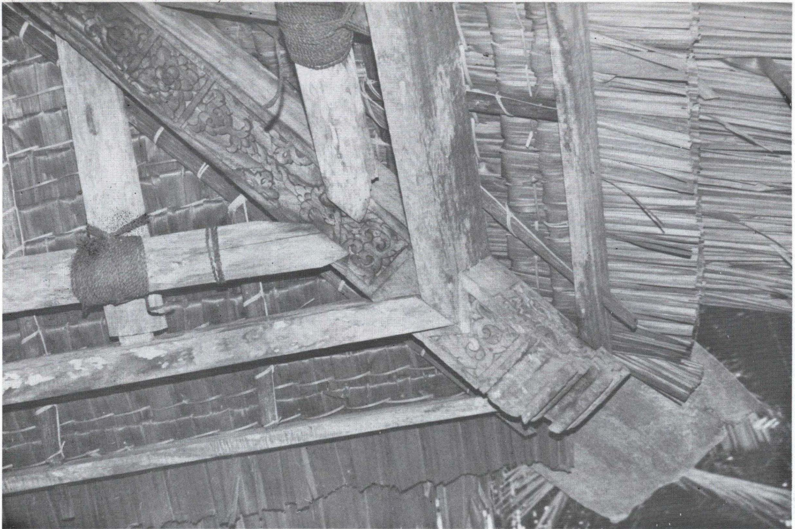
Konstruksi rusuk atap rumah tradisional di komplek Awe Getah.
