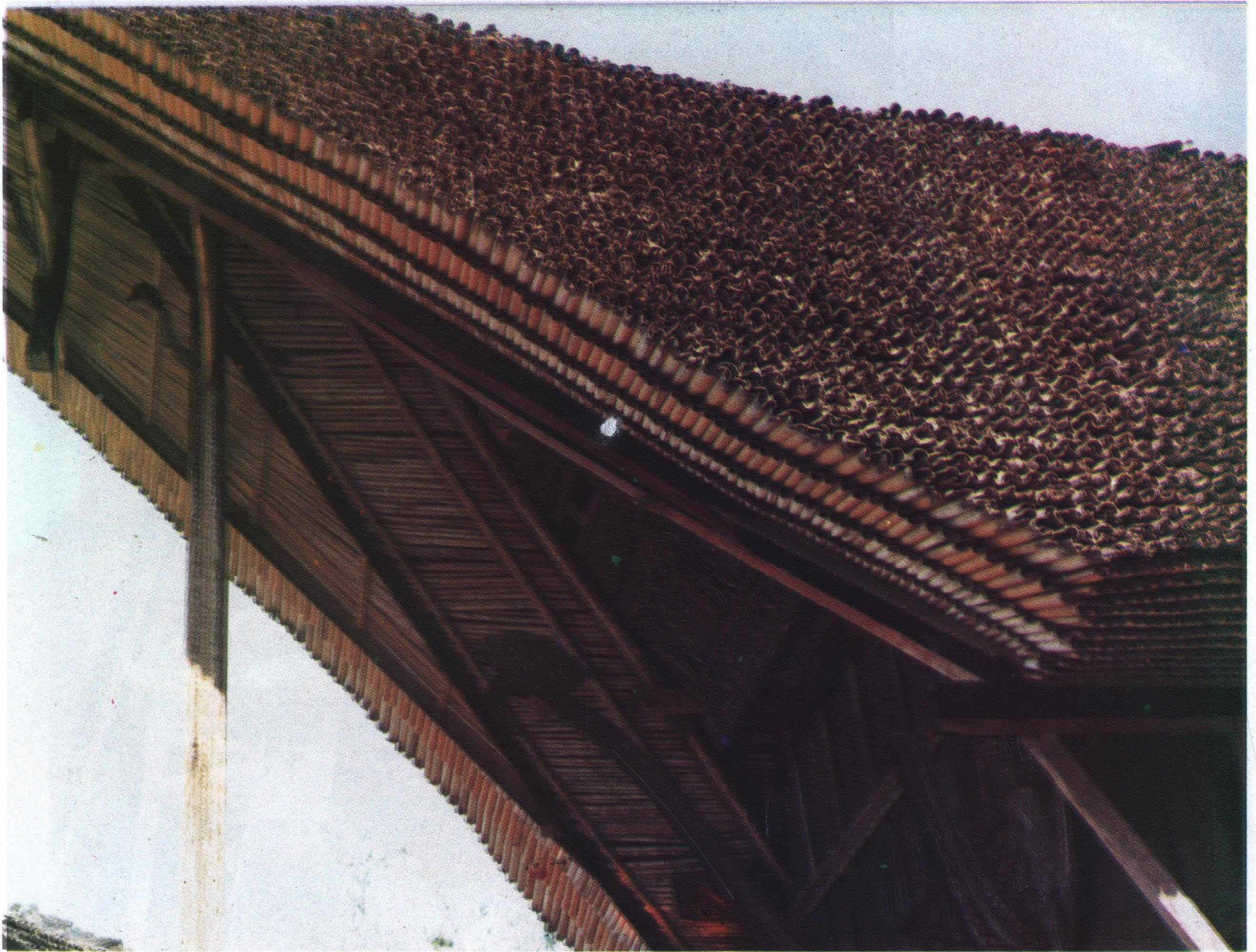
Bubungan pada Tongkonan di Ketekesu. Atap dibuat dari bambu yang dibelah dua dan disusun telungkup dan telentang untuk menahan air hujan.
