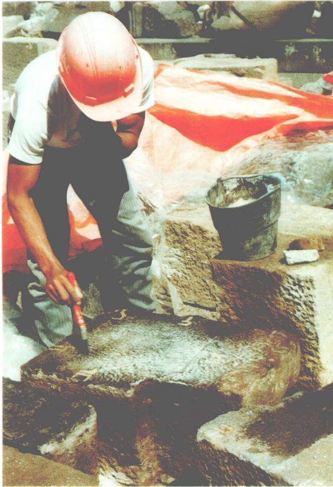
Foto no. 9 Cara pembersihan batu dengan bahan kimia AC. 322.
