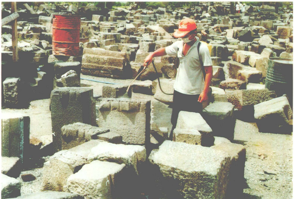
Foto no. 10 Penyemprotan bahan kimia untuk mengawetkan batu setelah batu dibersihkan.
