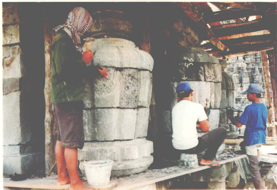
Foto no. 24 Pemahatan halus/penyelarasan batu amalaka atap candi.
