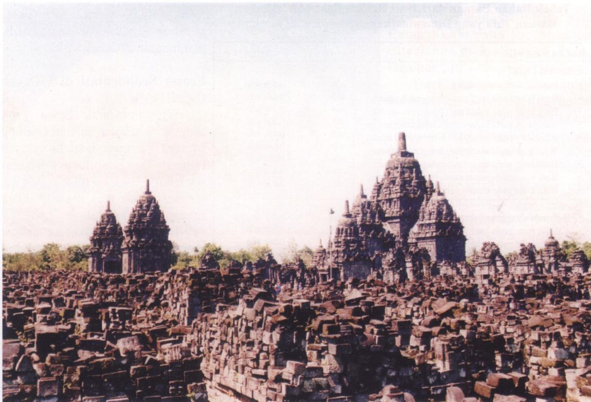
Foto 7: Candi Sewu dibangun dengan mempergunakan batuan andesit, tampak tumpukan balok-balok batu andesit yang siap untuk direkonstruksi
