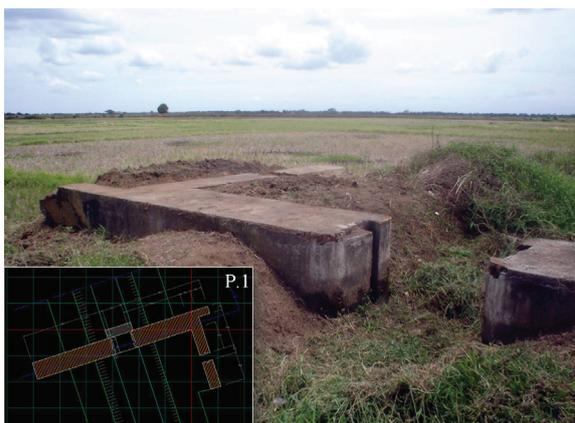
Foto 5. Struktur bendungan dan pintu air Cerucuk di Kanal Jongjing.
