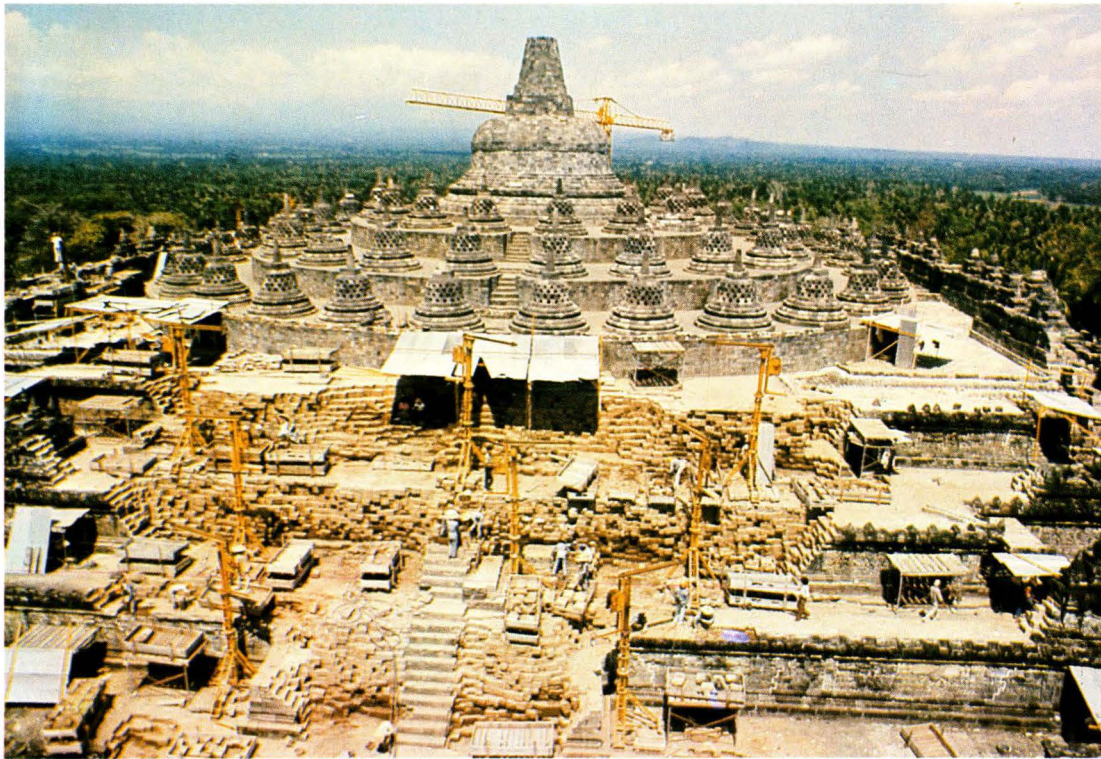
Kegiatan pemugaran yang dikerjakan pada setiap sisi candi dimulai dari tangga naik menuju ke samping kanan dan kiri.
