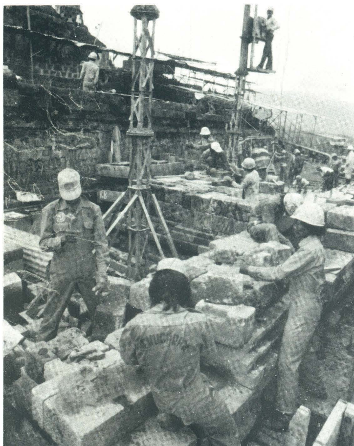
Batu-batu dinding candi dilepaskan satu demi satu untuk dibersihkan dengan saksama.
