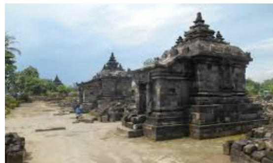
Gambar 13. Atap penampil tipe lereng bangku di Candi Plaosan Kidul (Sumber: https://id.m.wikipedia.org/wiki/Berkas:Candi_Plaosan_Kidul.jpg )
