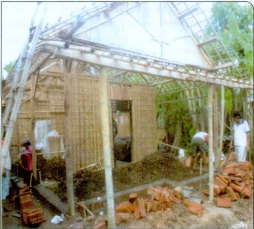
Foto 1: Kerangka Bentuk Rumah Klabang Nyander
