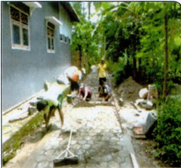
Foto 3: Pemasangan Konblok
