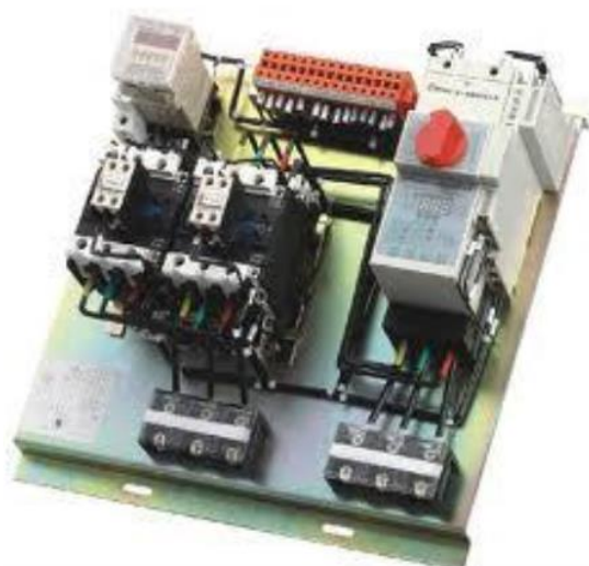
Gambar 42. Pengawatan Peralatan Kontrol Motor Induksi Tiga Fase dengan Pengasutan Y-Δ.
