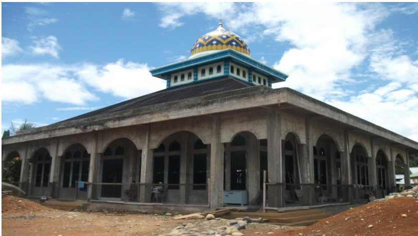
Gambar 5. Masjid Nurul Ikhlas, Masjid Desa Tunggang Sedang di Renovasi
