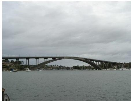
Gambar 100. Lengkung jembatan berbentuk parabola
