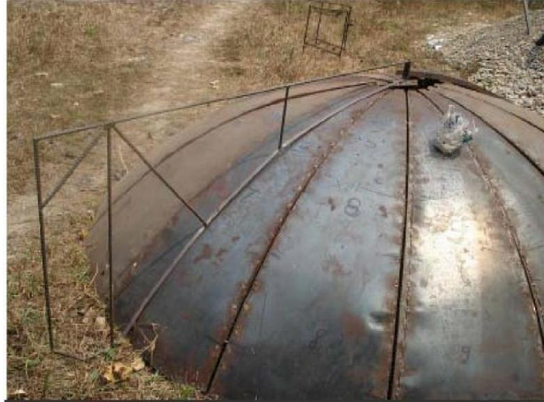
Pada diklat ini cetakan kubah terbuat dari tanah sisa galian yang diisikan ke dalam dinding melingkar. Untuk membuat bentuk kubah lebih simetris dan sesuai ketentuan/gambar maka digunakan mal yang terbuat dari besi yang dibuat khusus untuk membuat cetakan tersebut. Setelah selesai/ sesuai dengan ukuran dan bentuk yang diinginkan, maka cetakan tanah dilapisi dengan pasir basah setebal 1 cm.
