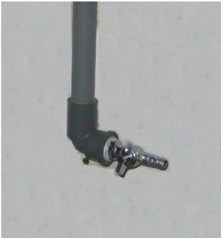
5) Hubungkan kran tersebut dengan kompor dengan menggunakan pipa PE
