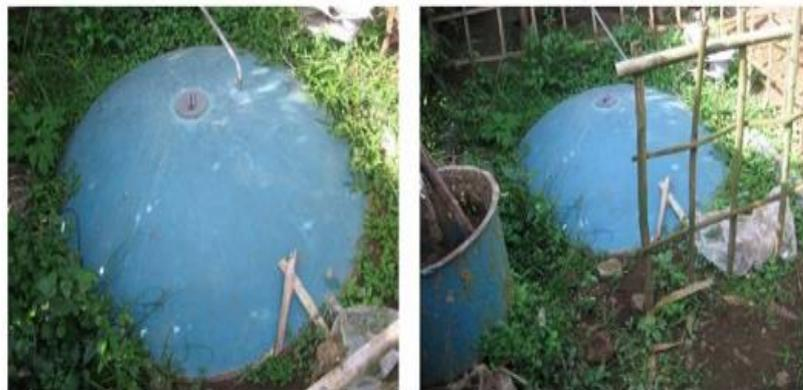
Gambar 6.6 Reaktor Biogas Dengan Bahan Dari Lembaran Baja
