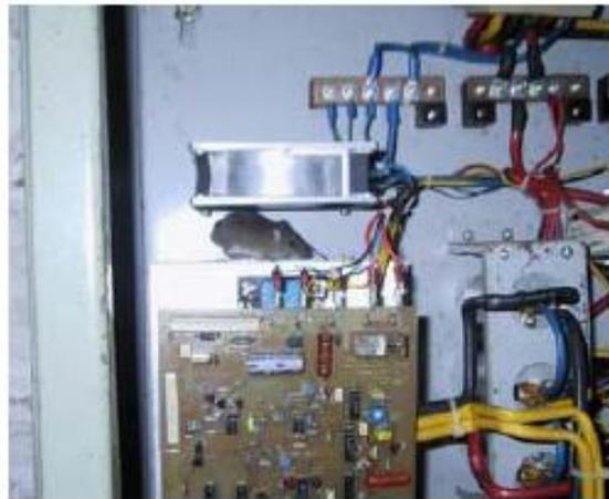
Gambar 7 | Pelanggan mengganti sekering dengan kabel (sangat berbahaya, hindari perbuatan ini)
