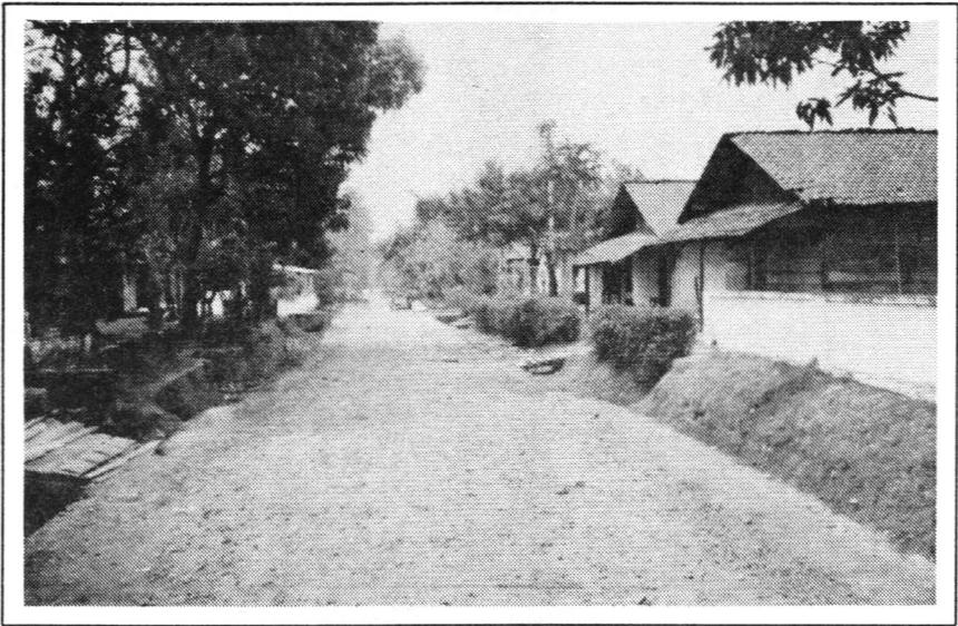
Gambar 2. Sebagian jalan masih berupa tanah yang dikeraskan
