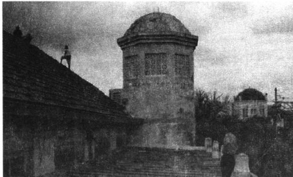
si atap asli menggunakan rangka kayu, mengakibatkan dinding terluar mengalami memiringan. Untuk menghindari terjadinya kerusakan yang lebih fatal, diusulkan oleh perencana konservasi untuk mengganti rangka atap datar dengan menggunakan bahan besi, dengan pertimbangan rangka besi dapat bekerja, difungsikan sebagai ‘pengikat’ struktural untuk dinding terluar.
