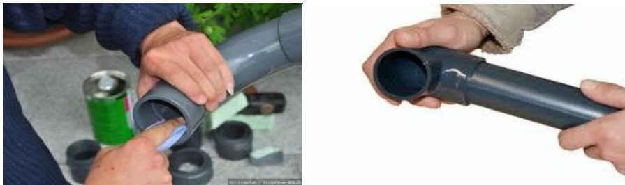
Gambar 1.9 Menyambung soket PVC
