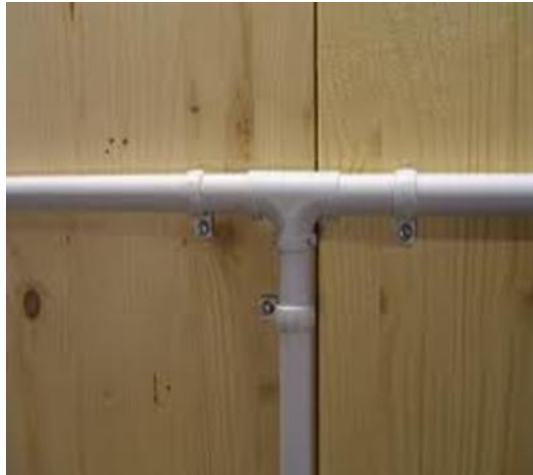
Gambar 1.11. Sambungan pipa cabang
