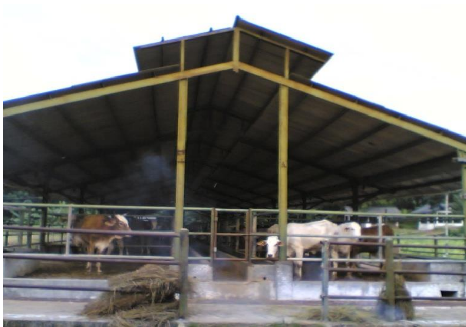
Gambar 3. Kandang sapi yang tipe atapnya berbentuk monitor dari bahan asbes.
